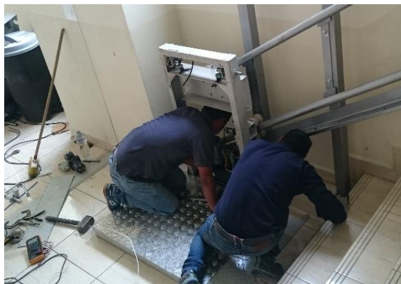
Figura 105. Instalación del motor principal
