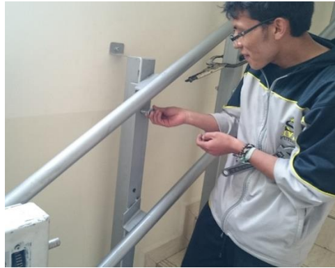
Figura 103. Fijación de los rieles
