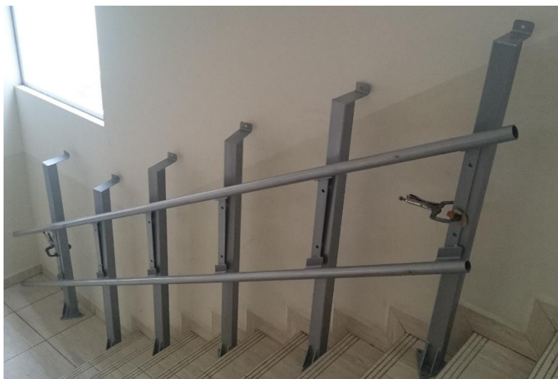
Figura 100. Calibración postes autoportantes
