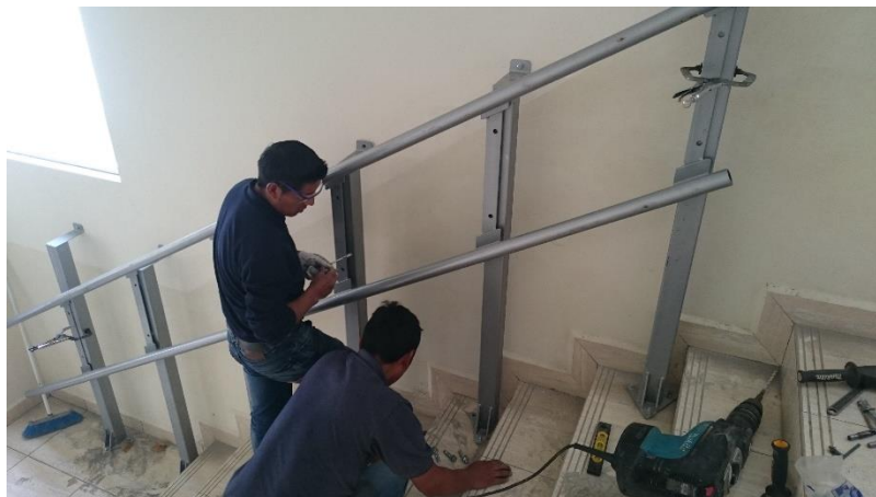
Figura 101. Fijación de los postes a concreto
