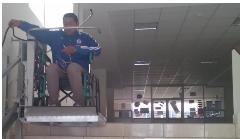
Figura 124. Ingreso al salvaescaleras
