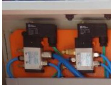
**Figura 117 Conexión neumática de electroválvulas.**
