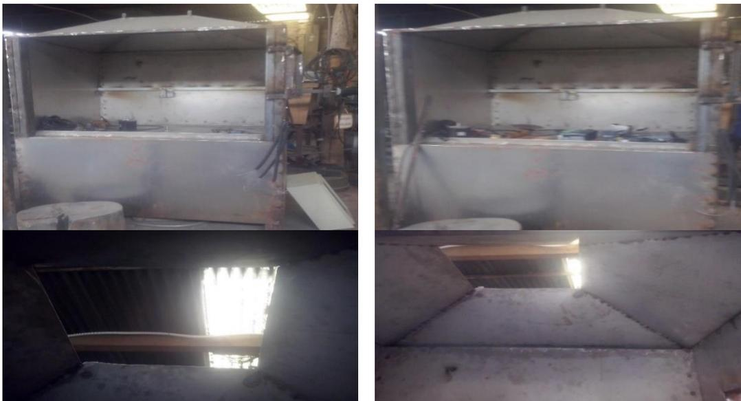
**Figura 104 Vista del recubrimiento y formación del cono de succión.**
