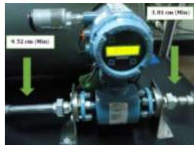
Figura 6: Instalación del transmisor 8732 E en la tubería.
