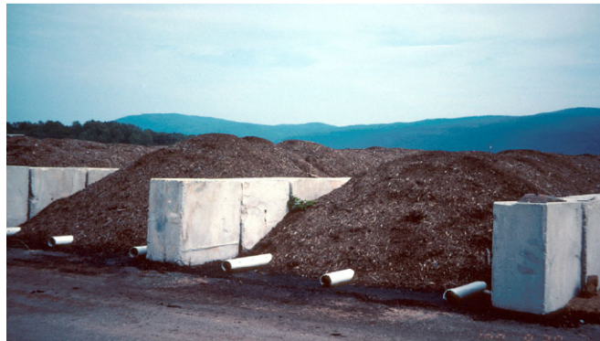
Figura 20 Pilas estáticas con aireación pasiva Fuente:(Alvarez, 2003)
