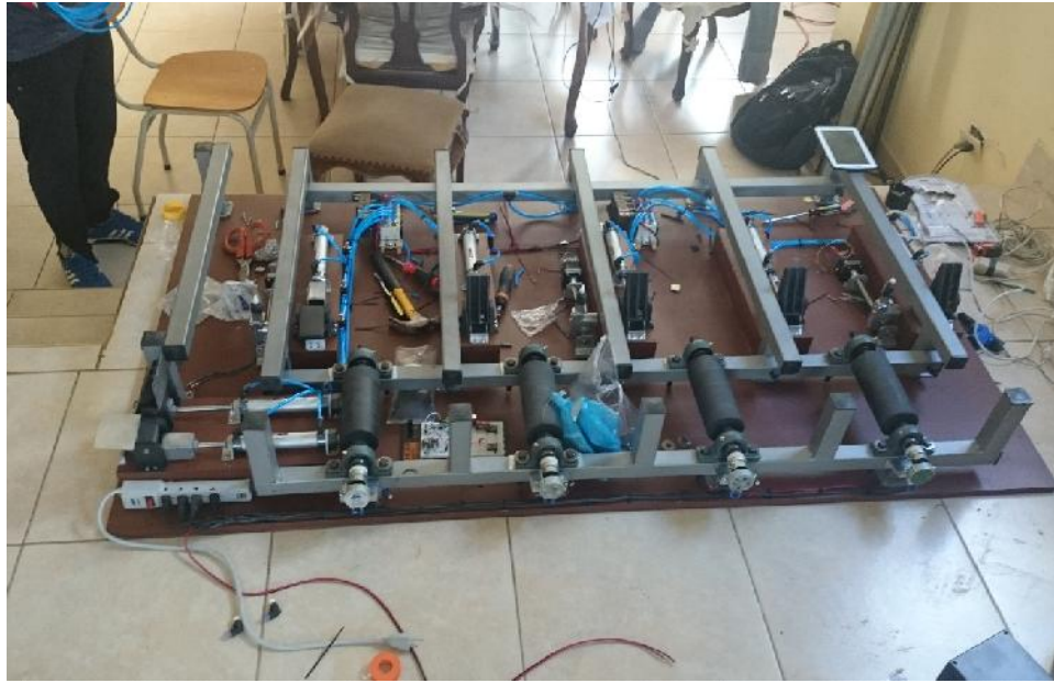
Figura 255. Inicio del cableado tanto neumático como eléctrico.
