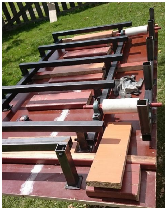
Figura 249. Verificación de medidas una vez ubicado todos los perfiles de la máquina sobre la base del prototipo.
