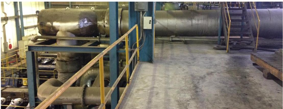
**Figura. 16** Tubos de entrada y salida de gases.
