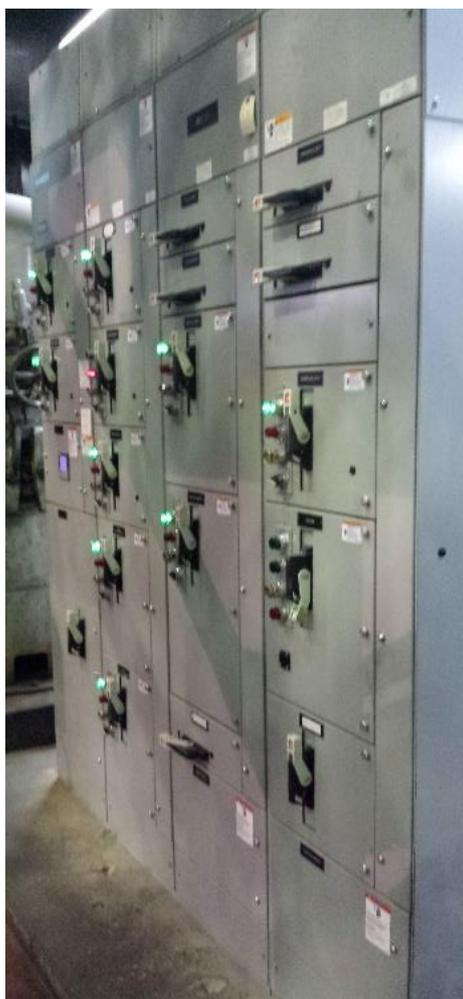
**Figura. 32** MCC para el encendido y apagado de la unidad 3
