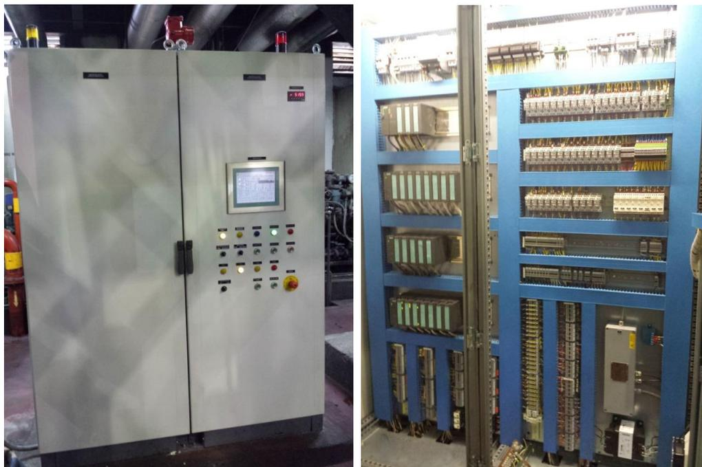
**Figura. 108** Vista exterior e interior del Tablero de Control Unidad 3
