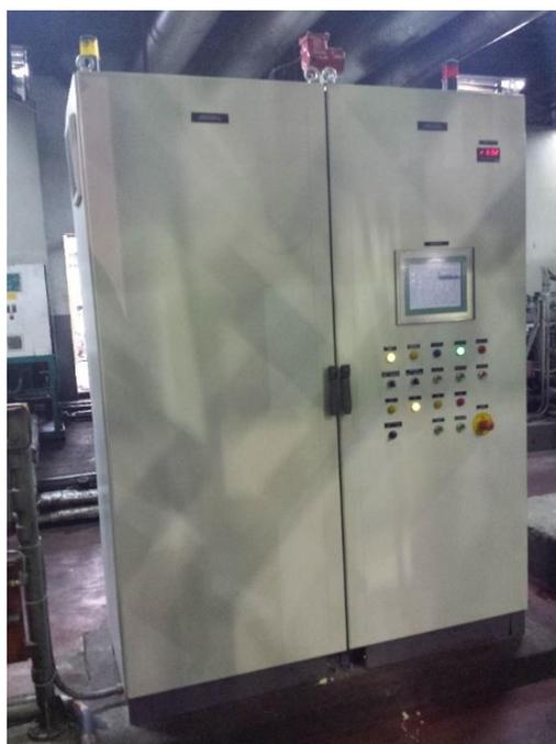
**Figura. 3** Tablero de control instalado del motor generador 3.
