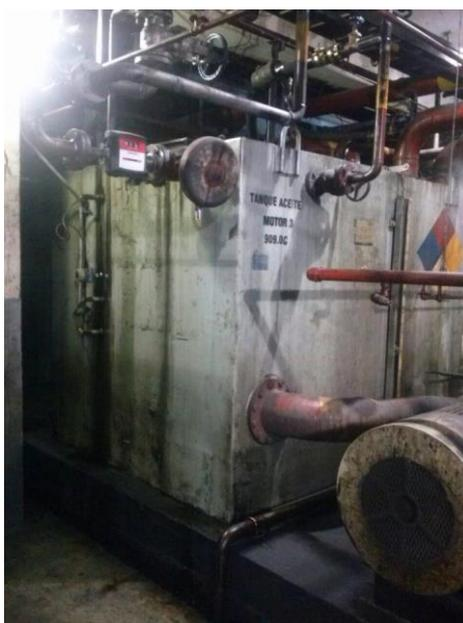
**Figura. 13** Tanque aceite lubricante.
