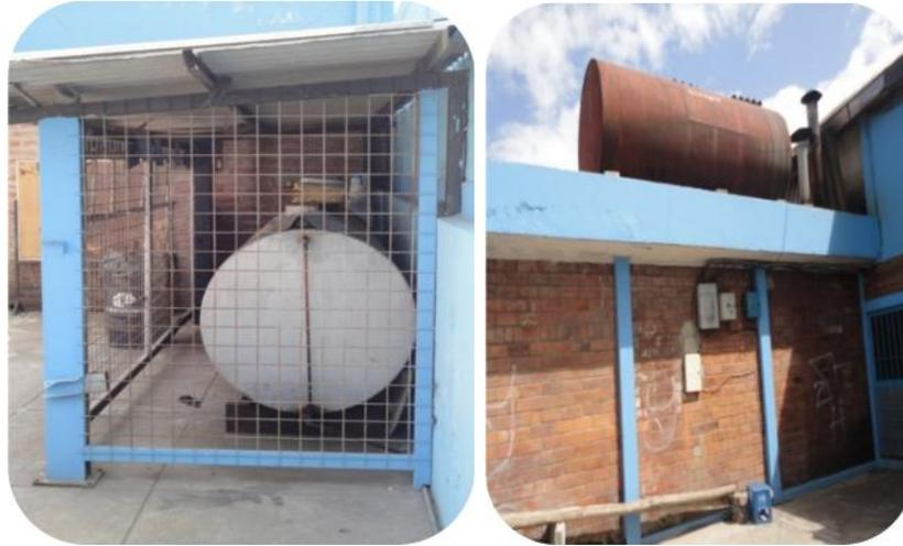
**Figura No. 34** Ausencia De Señalización En Tanques De Reserva
