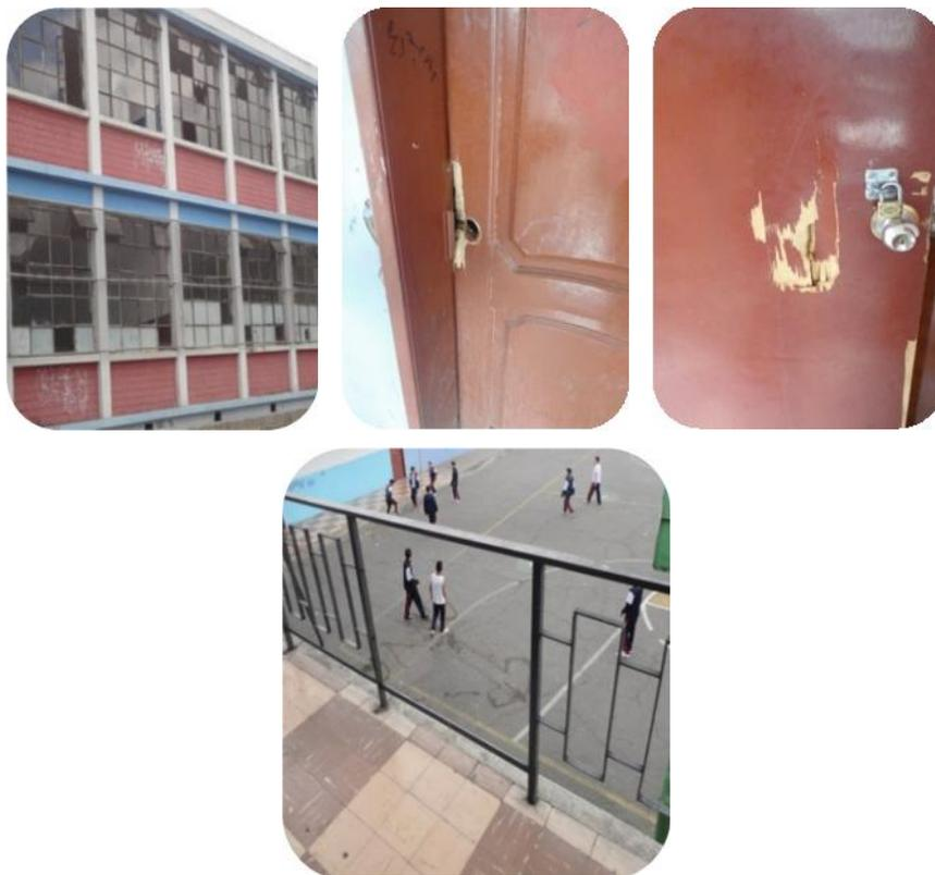
**Figura No. 33** Deterioro de barandas, puertas, ventanas
