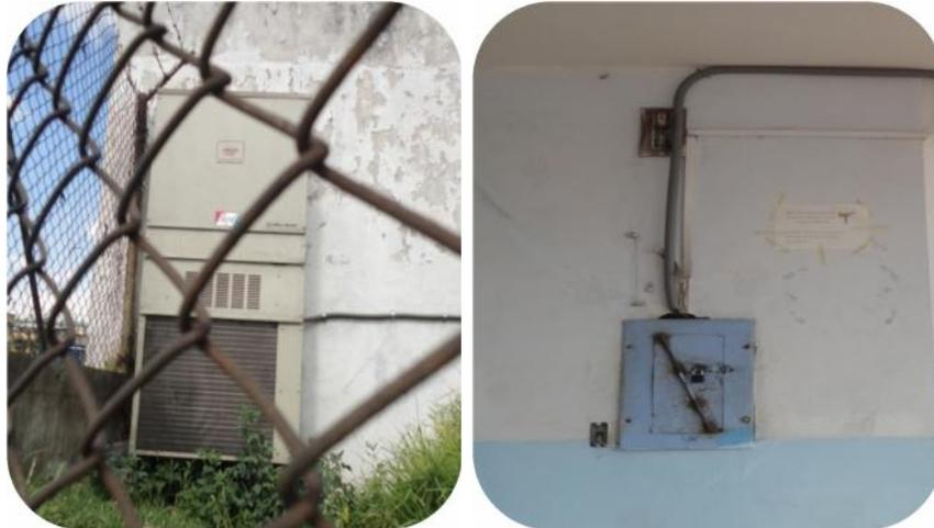
**Figura No. 35** Ausencia De Señalización De Riesgo Eléctrico.
