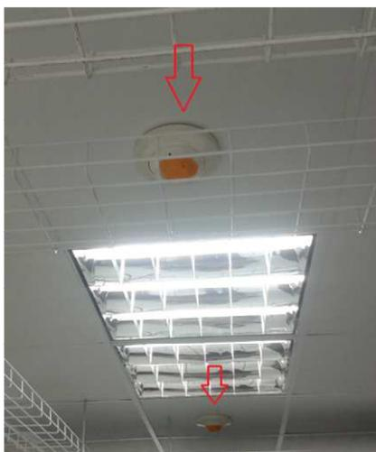
**Figura 121 Sensores fotoeléctricos ubicados en el techo falso**
