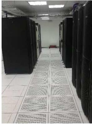
**Figura 10 Paneles perforados**
