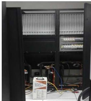
**Figura 115 Unidad evaporadora del A/A**
