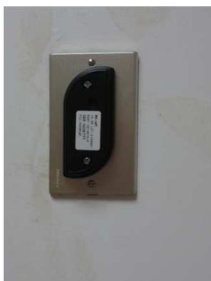
**Figura 128 Lector utilizado en el sistema de control de accesos**
