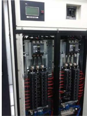
**Figura 105 Instalación del PDU**
