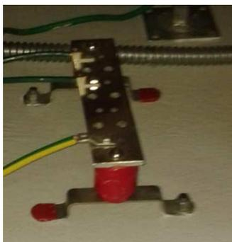
**Figura 111 Barra colectoras utilizada en la implementación**
