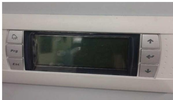
**Figura 114 Panel de seteo del aire acondicionado**
