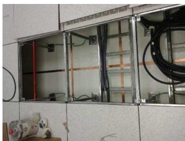
Figura 9 Paneles de piso falso
