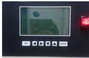
**Figura 106 Panel de configuración PDU**
