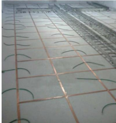
**Figura 86 Instalación malla de alta frecuencia**
