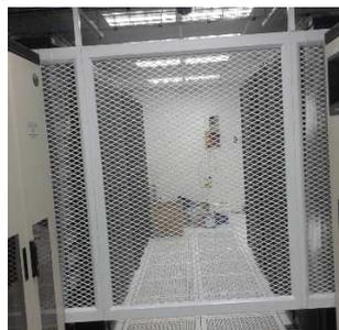
**Figura 96 Malla de acero inoxidable instalada**
