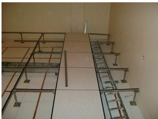
**Figura 88 Paneles de piso de acceso elevado**
