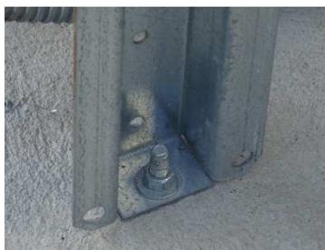
**Figura 118 Anclajes de condensadoras**
