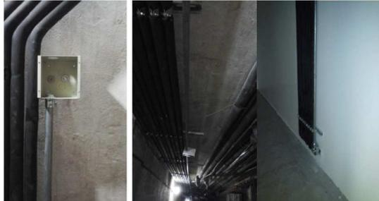
**Figura 113 Sistema de tuberías para A/A**
