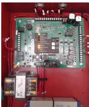
**Figura 120** Tarjeta electrónica del panel
