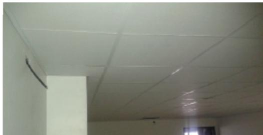
**Figura 95 Vista de paneles que conforman el techo falso**
