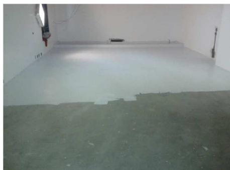
**Figura 84** Aplicación pintura anti estática
