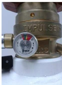
**Figura 125 Switch de presión incorporado en el tanque**
