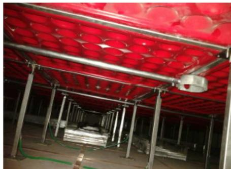
**Figura 90 Instalación de piso falso vista desde abajo**
