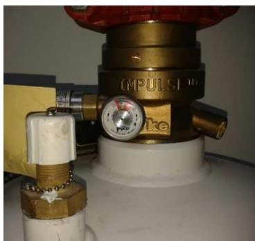
Figura 45 Válvula de impulso
