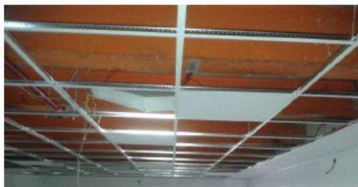
**Figura 93 Estructura para paneles de techo falso**
