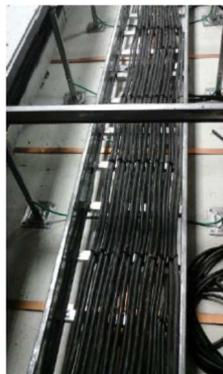
**Figura 110 Conexiones eléctricas vistas desde el piso falso**
