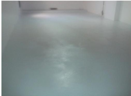
**Figura 85 Recubrimiento de pintura en todo el CD**
