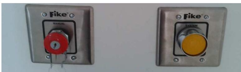
**Figura 122 Botones de aborto y descarga del sistema contra incendios**
