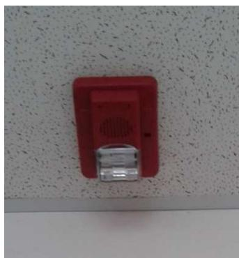
**Figura 123 Luz estroboscópica del sistema contra incendios**
