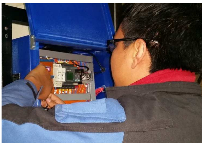
Figura 73. Montaje armario de control
