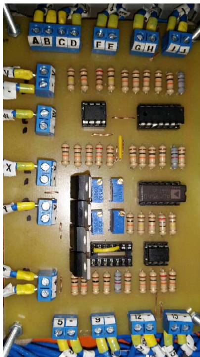
Figura 70. Placa de acondicionamiento de sensores
