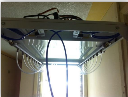
Figura 77. Instalación secciones A y B
