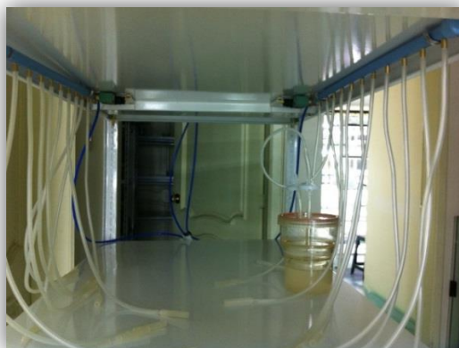
Figura 78. . Instalación secciones C y D
