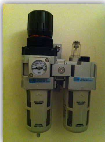
Figura 81. Instalación unidad de mantenimiento
