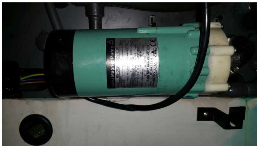
Figura 5.17 Bomba usada para la Recirculación de químico revelador
