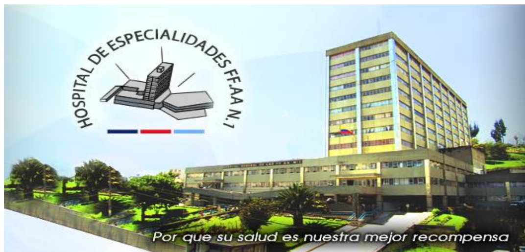
Figura 11. Vista Panorámica del Hospital
