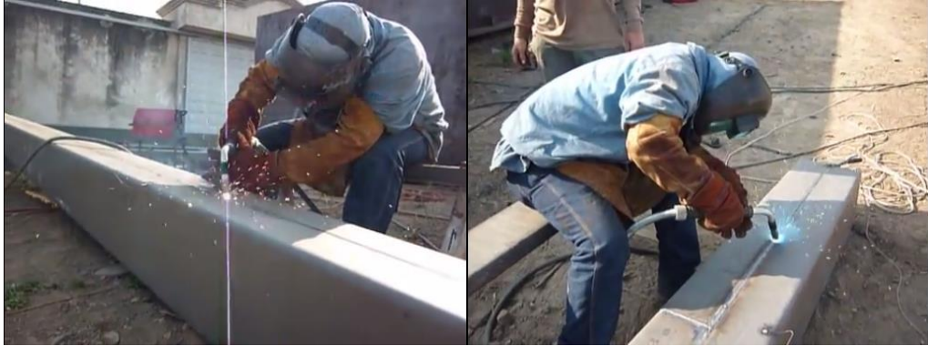
Figura 1.2: Suelda manual de viga CG. (HXNM, 2014)
