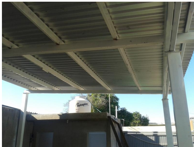
Figura 1.1: Estructura con vigas CG. (HXNM, 2014)
