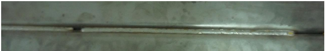
Figura 6.30: Ensayo N°20 soldadura.
