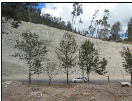
Figura 17: Vista de la Zona de Implantación hacia la vía Cuenca – Azogues.
