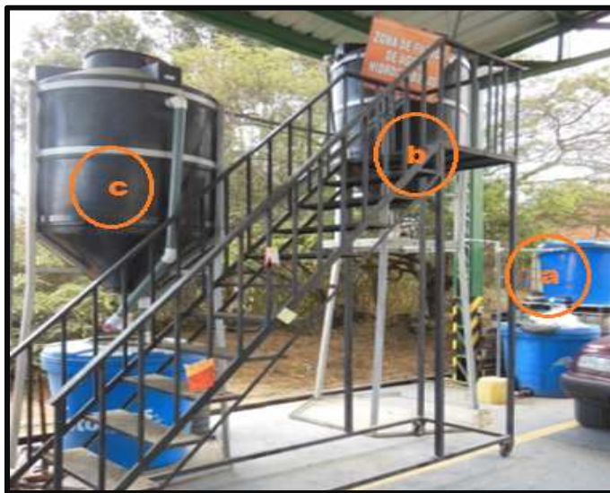
Figura 5: Biodigestor para tratar el Agua Remanente que se Genera del Tratamiento del Aceite Usado
