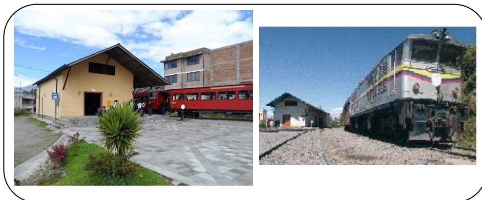
Figura 48. Estación de Tren Tambillo – Tambillo
