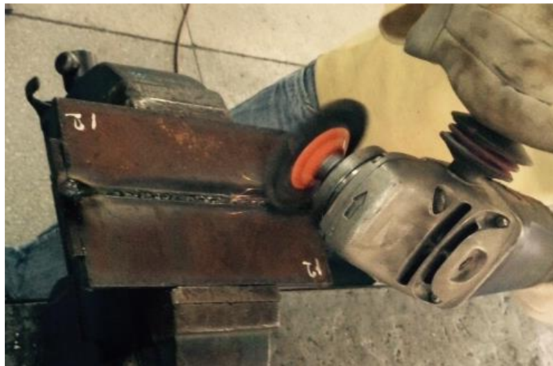
Figura 24 Limpieza del cordón de raíz con la técnica del grateado
