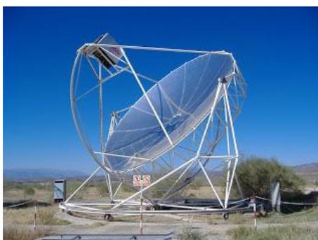
**Figura 6.-** Captador Disco Stirling.
