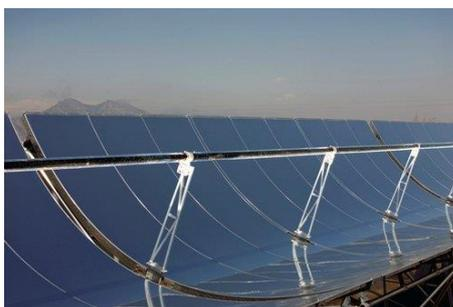
**Figura 4.-** Captación solar por espejos Cilindro-parabólicos.
