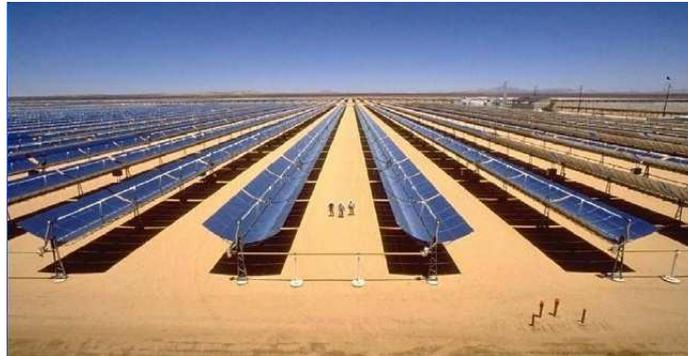
**Figura 15.-** Campo típico de filas de captadores de canal parabólico.
