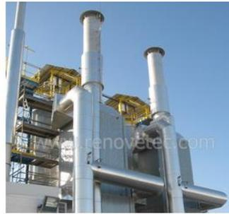
**Figura 20.-** Caldera de gas natural implementada en una central termosolar.
