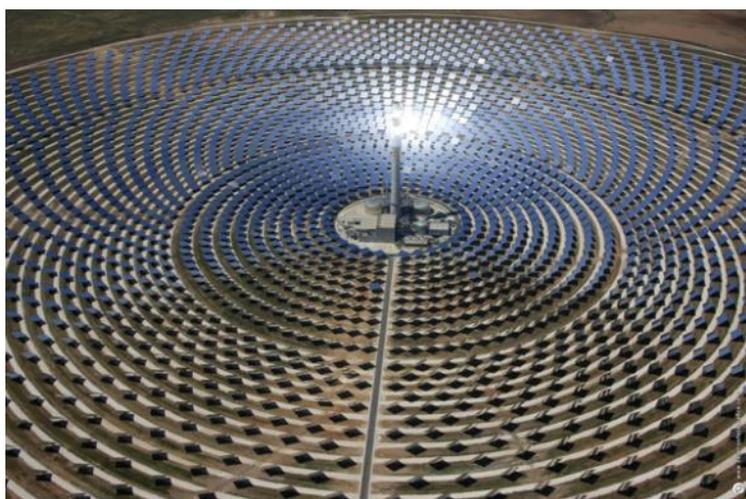
**Figura 3.-** Captación solar por Torre con campo de espejos.
