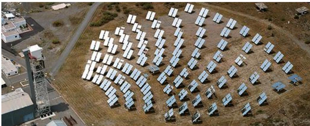
**Figura 8.-** Vista de una torre y su campo de helióstatos.
