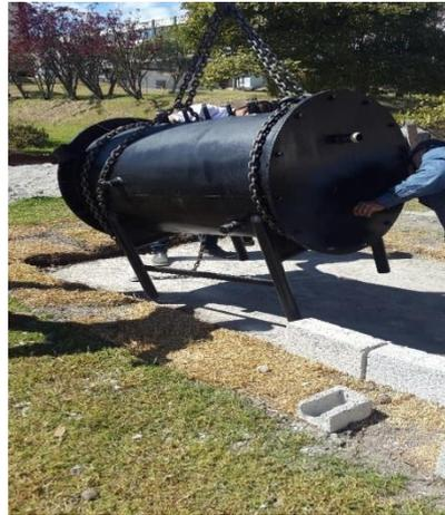
**Figura 66.-** Colocación del caldero en el sitio de operación.
