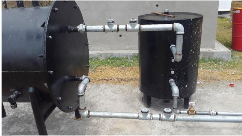
**Figura 70.-** Conexión del caldero con el reservorio de aceite y CSP.
