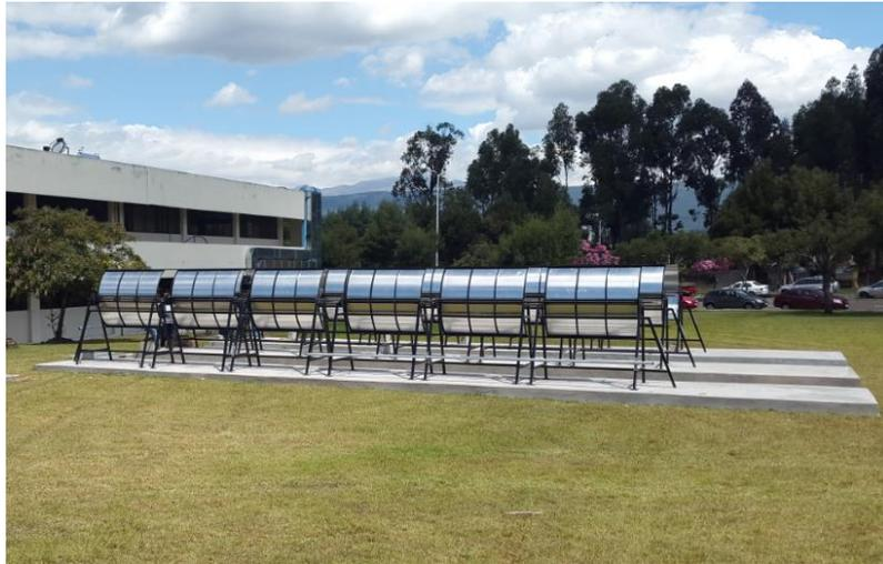
**Figura 68.-** Colectores cilíndricos parabólicos Central Termosolar.
