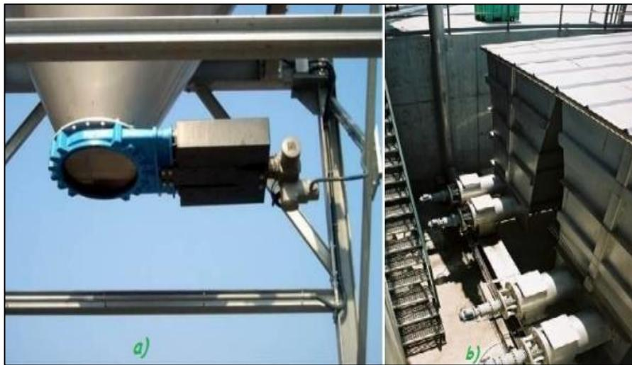
**Figura 1.21: Descarga por: a) Gravedad. b) Forzada.**
