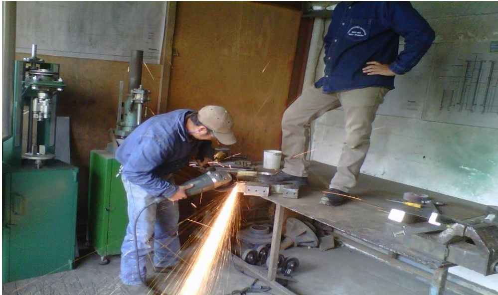
Figura 47: Limpieza del material base antes de la soldadura
