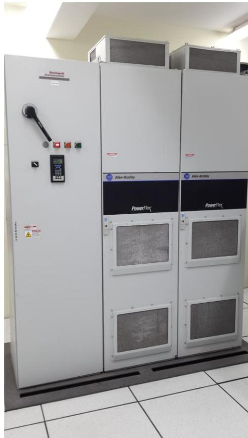
**Figura 57.** Variador de velocidad PowerFlex 700H del poliducto
