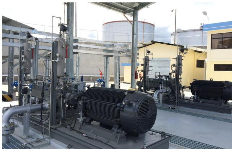
**Figura 6.** SKID de bombeo redundante.
