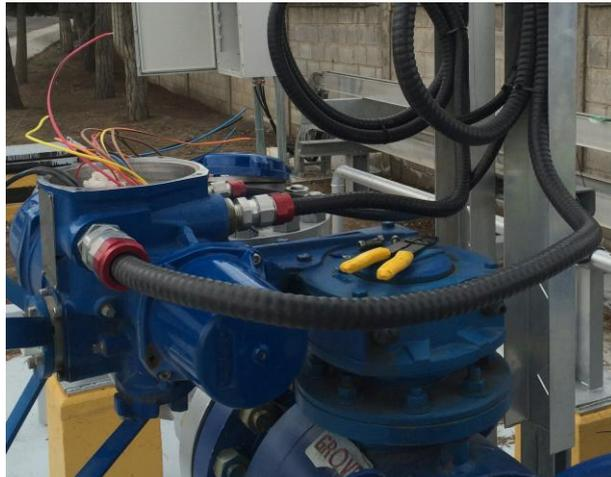
**Figura 54.** Cables conectados en válvula motorizada MOV.
