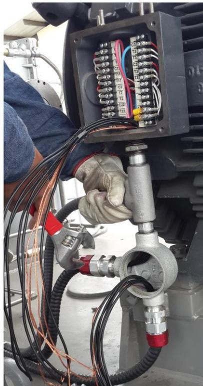
**Figura 39.** Conexión de RTDs de los devanados del motor de la bomba 221.
