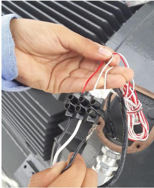
**Figura 40.** Conexión de RTD de cojinete D.E. del motor de la bomba 221.
