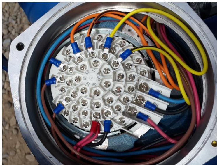
**Figura 55.** Conexión de válvula motorizada MOV.
