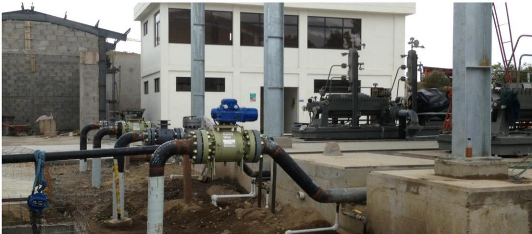
**Figura 51.** Válvulas de succión y descarga del SKID de bombeo durante etapa de construcción.
