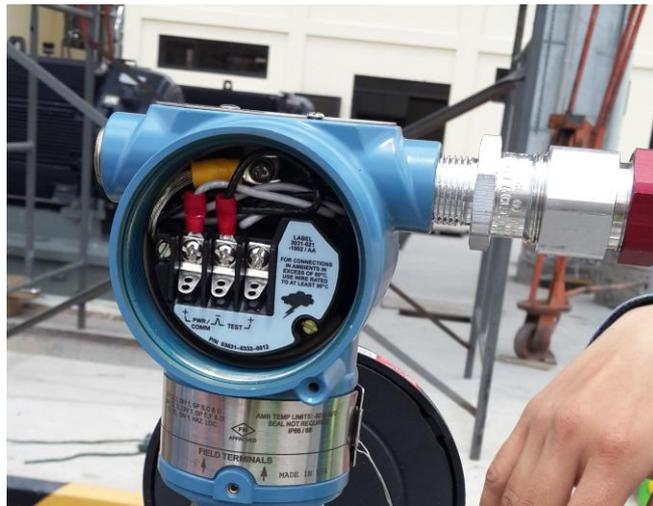
**Figura 32.** Conexión de transmisor de presión.
