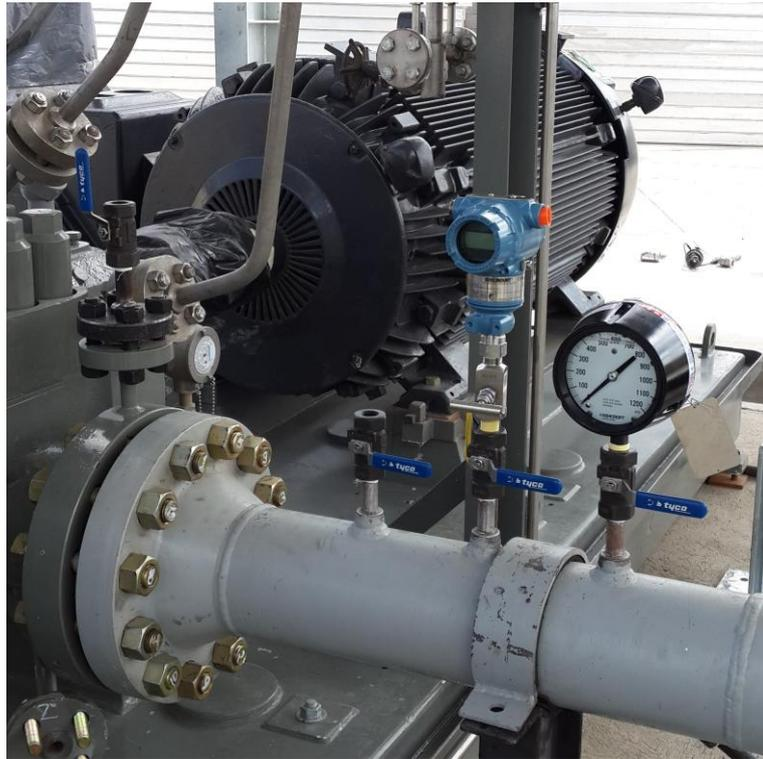
**Figura 33.** PI y PIT montados en succión de bomba 220.
