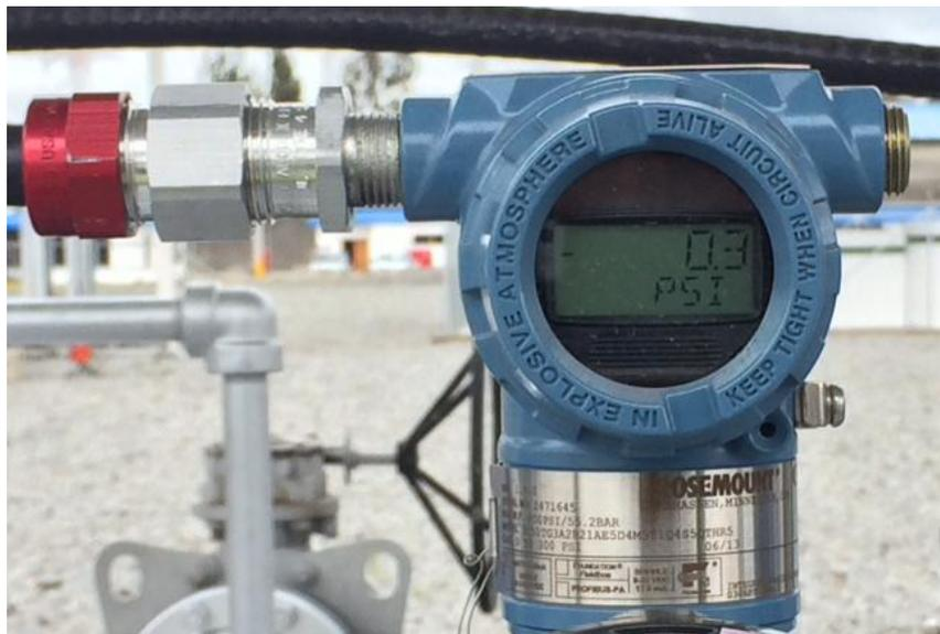
**Figura 89.** Transmisor de presión en pruebas de lazo. Lectura en campo
