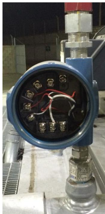
**Figura 38.** Instalación completa TIT en descarga de bomba 220.
