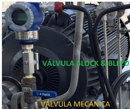
**Figura 29.** Instalación de accesorios mecánicos.
