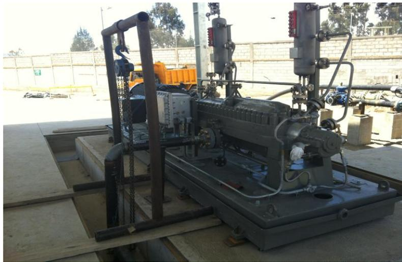
**Figura 7.** SKID de bombeo. Bomba centrífuga.
