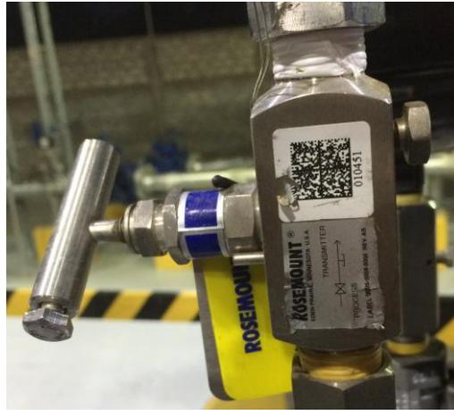
**Figura 28.** Válvula de bloqueo y purga Rosemount.
