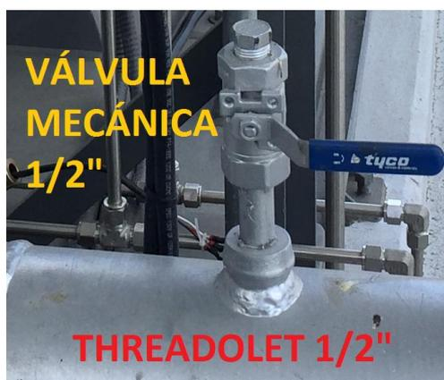
**Figura 27.** Instalación de accesorios mecánicos.
