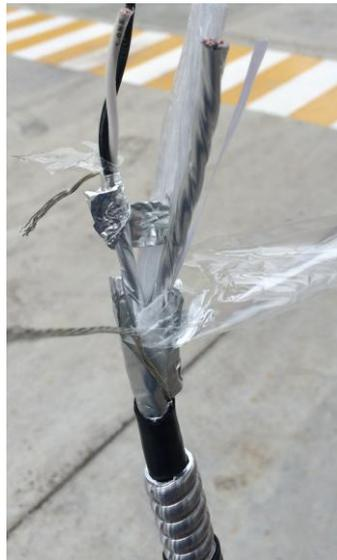
**Figura 31.** Cable armado 2Px16AWG. Apantallado.
