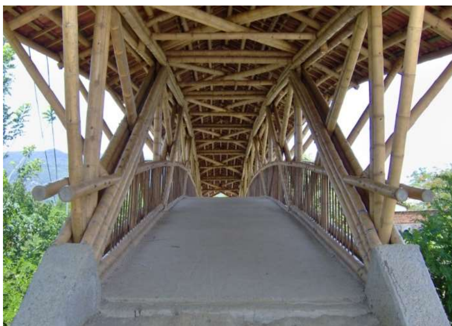
Figura 6.60. Loseta de hormigón con malla electrosoldada, puente Santa Fé (Stamm, 2010).
