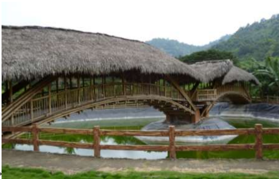
Figura 6.70. Cubierta vegetal de Cade, puente San Plácido, Manabí (Fuente: Autor, 2014).
