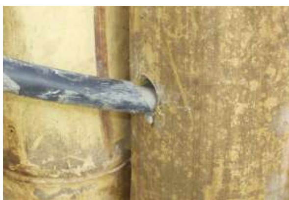
Figura 6.15. Relleno de canuto con mortero 1:2 para anclaje a sobre-cimiento (FUNDEGUADUA A. , 2010).
