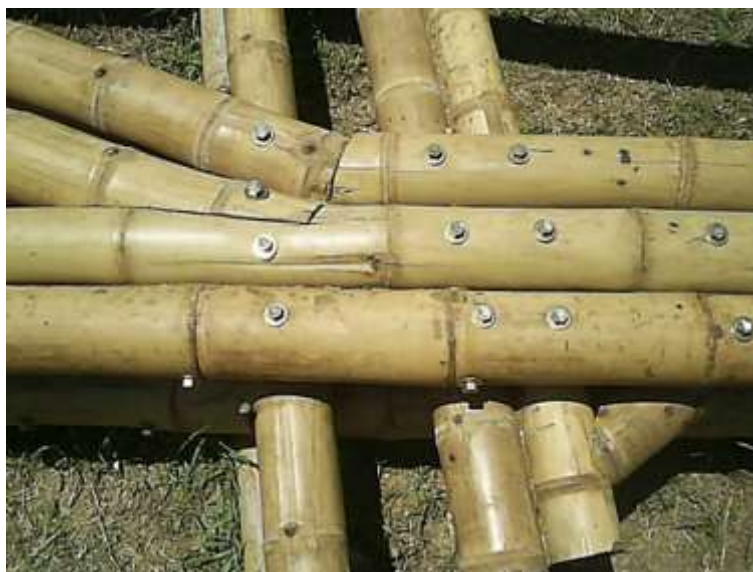
Figura 6.51. Unión de diagonales a vigas cargadoras (Stamm, 2010).
