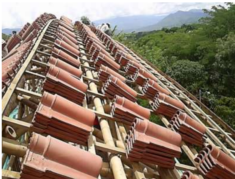
Figura 6.68. Cubierta de teja en puente Santa Fe (Stamm, 2010).
