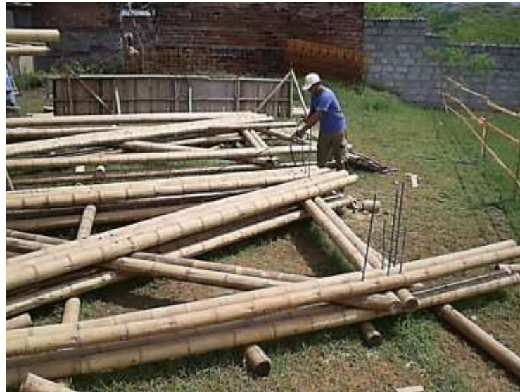
Figura 6.52. Colocación de las vigas de piso, de carga y de techo en forma de sánduche (Stamm, 2000).
