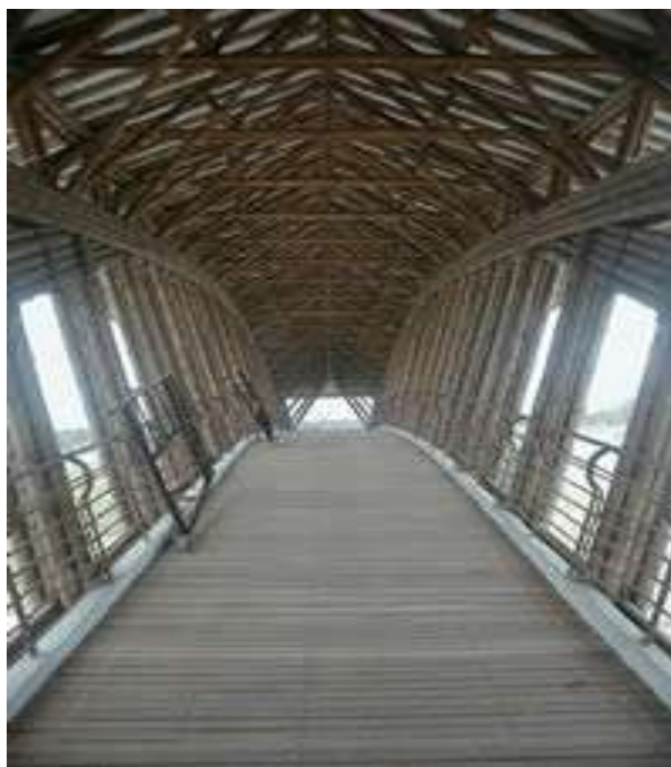
Figura 6.64. Entablado de madera, Puente Bogotá (FUNDEGUADUA A. , 2010).
