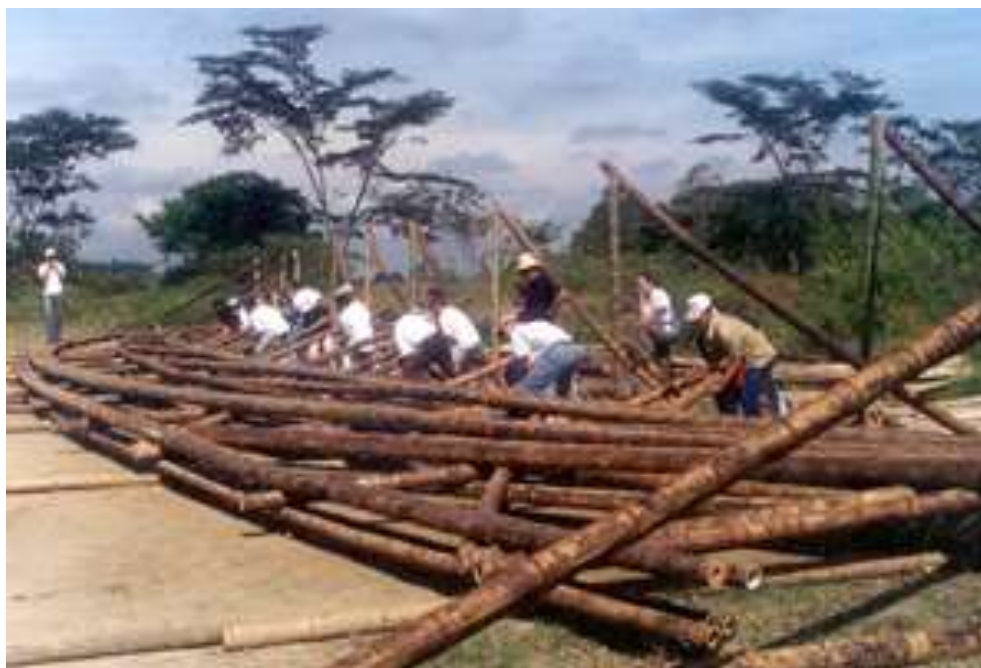
Figura 6.53. Colocación de la cercha para el levantamiento mediante grúa (Stamm, 2000).
