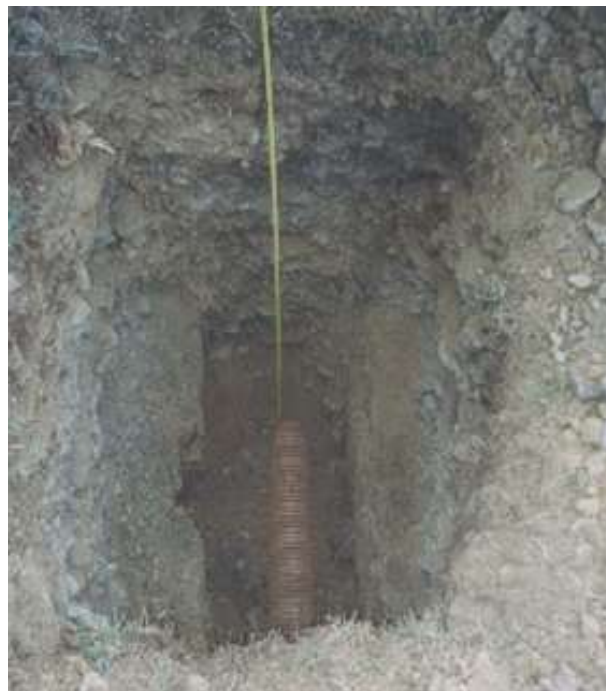
Figura 6.11. Profundidad de desplante entre 1.50 y 2.40 (Lucker, 2010).
