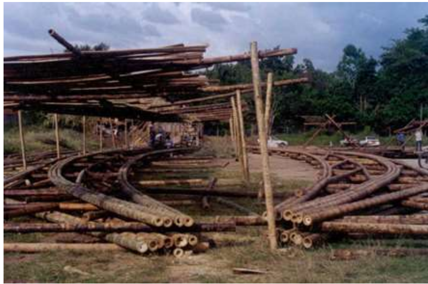
Figura 6.43. Prefabricación de una cercha con vigas cargadoras (Stamm, 2000).
