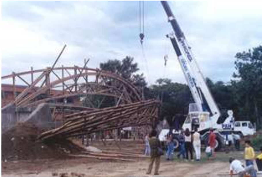
Figura 6.55. Levantamiento de la cercha mediante la grúa (Stamm, 2000).
