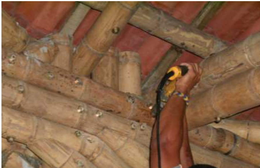
Figura 6.71. Ajuste de pernos con taladro (Stamm, 2010).
