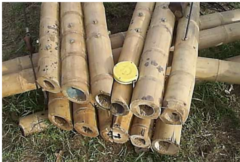
Figura 6.47. Unión de una viga inferior con un viga de carga principal (Stamm, 2010).
