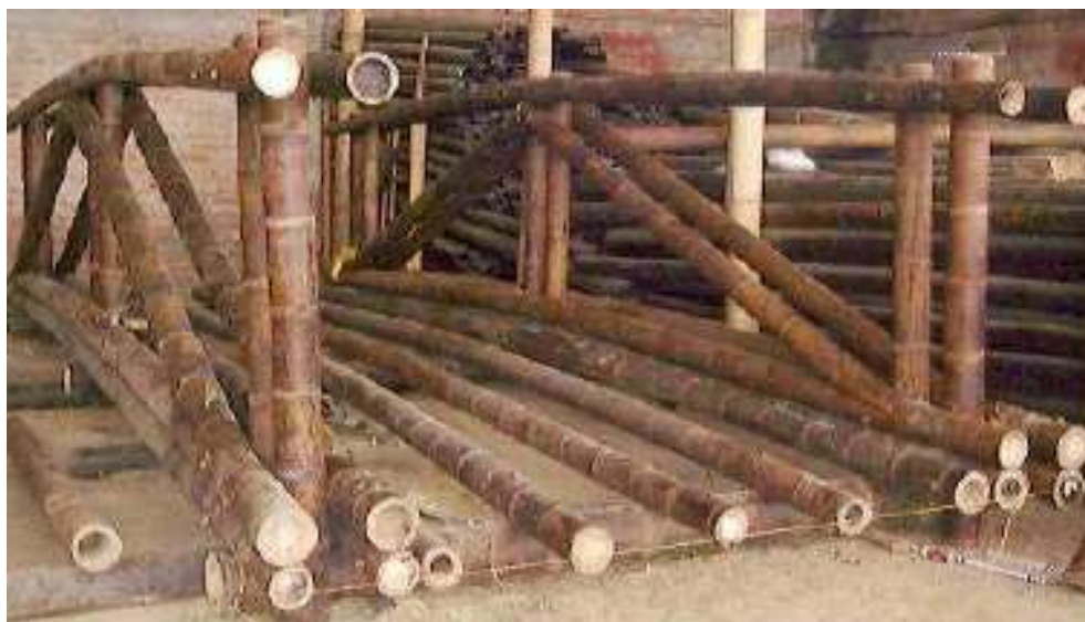
Figura 6.48. Prefabricación de barandales (Stamm, 2000).
