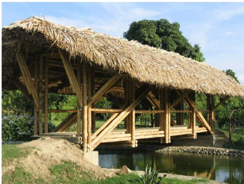
Figura 6.69. Cubierta vegetal de Cade, puente El Bolero (FUNDEGUADUA A. , 2010).
