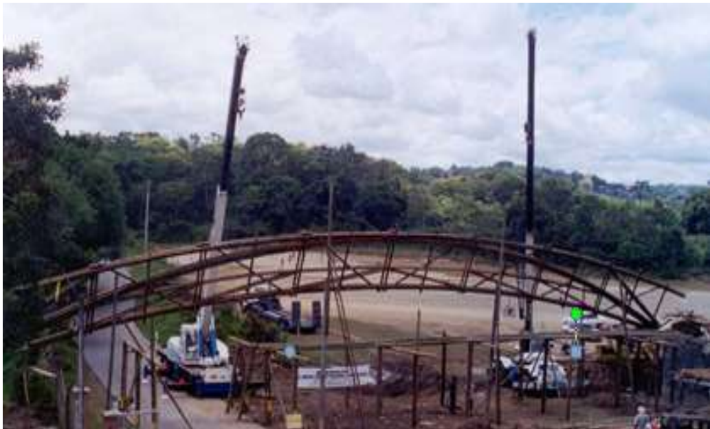
Figura 6.56. Montaje de la cercha (Stamm, 2000).
