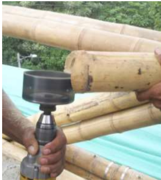
Figura 6.22. Corte boca de pez (Stamm, 2010).
