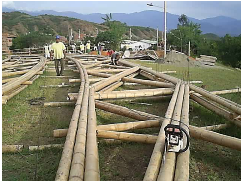
Figura 6.41. Prefabricación de una cercha para puente peatonal de GAK (Stamm, 2010).
