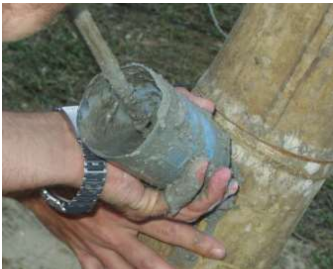
Figura 6.32. Relleno con mortero 1:2 para formar una viga compuesta (FUNDEGUADUA A. , 2010).
