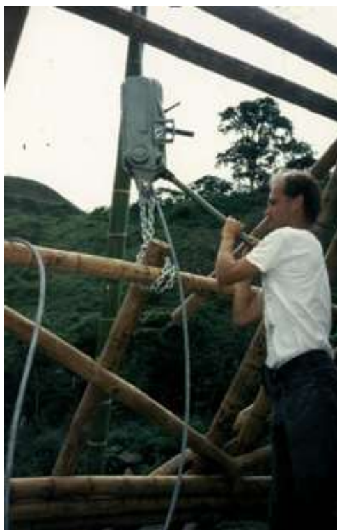
Figura 6.54. Aseguramiento de la grúa a la cercha (Stamm, 2000).
