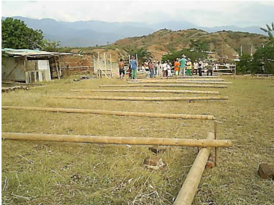
Figura 6.7. Colocación del cable para la línea cero, y guadúas perpendiculares al cable para marcación de cotas (Stamm, 2010).
