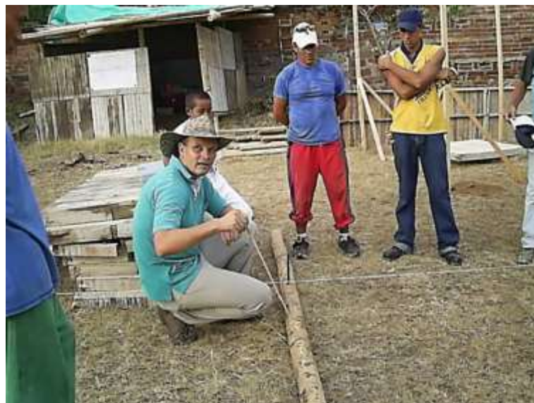
Figura 6.8. Colocación de cable y guadúa perpendicular (Stamm, 2010).
