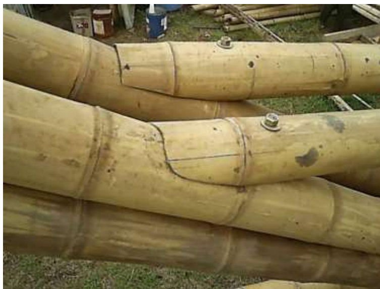
Figura 6.50. Unión de diagonales a vigas cargadoras (Stamm, 2010).
