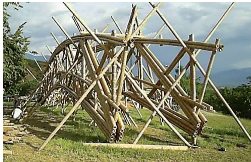
Figura 6.45. Prefabricación de una cercha, se observan uniones, vigas compuestas y columnas (Stamm, 2000).
