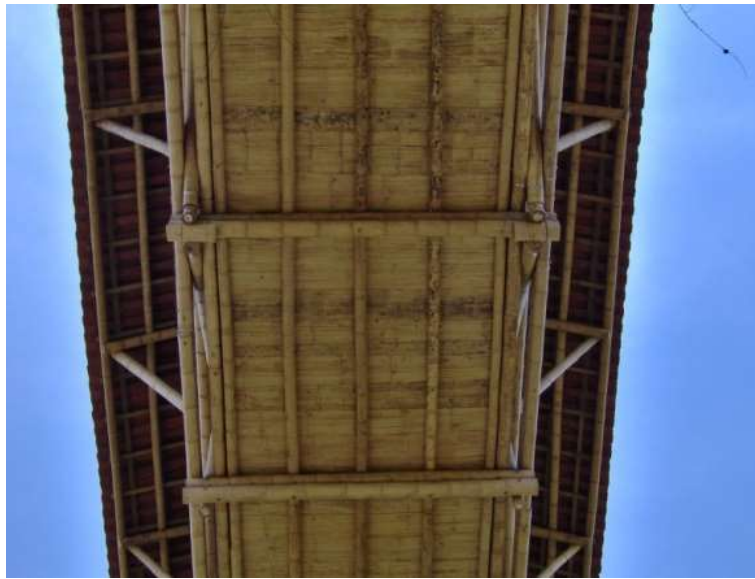
Figura 6.62. Latillas de culmos de GAK, puente Bogotá (Stamm, 2010).
