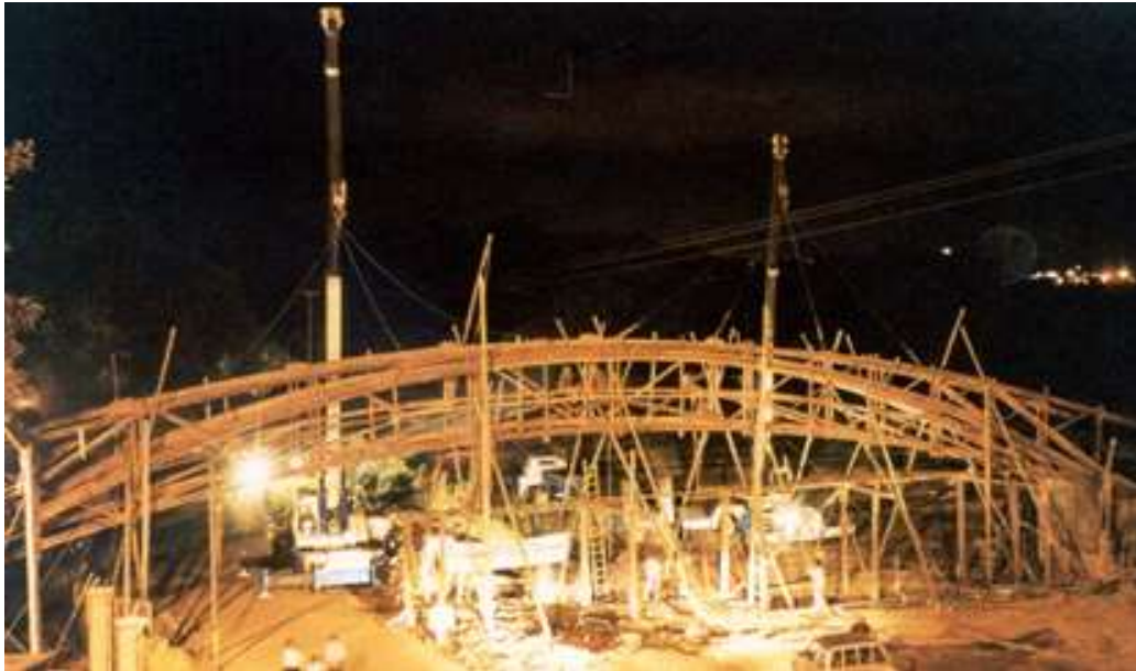
Figura 6.57. Montaje de la cercha (Stamm, 2000).
