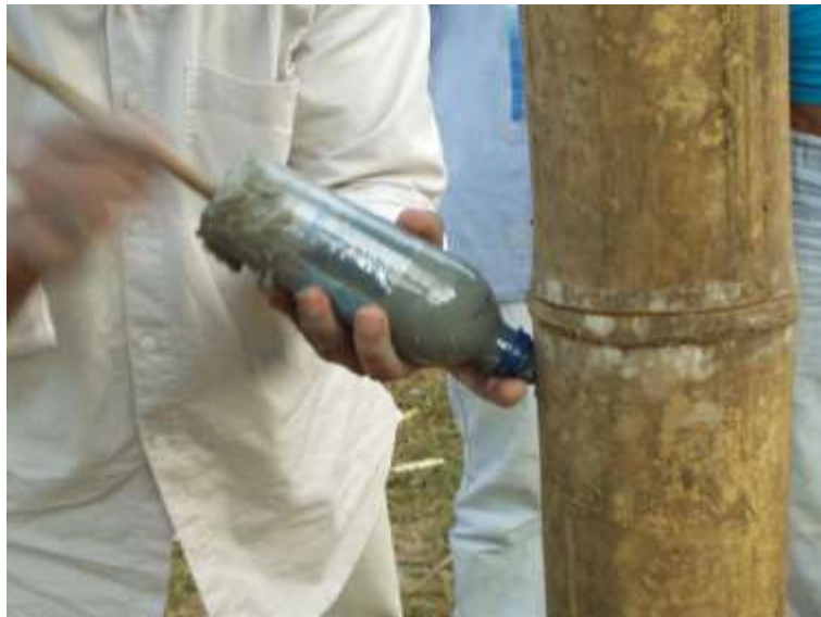
Figura 6.26. Relleno con mortero 1:2 para uniones longitudinales (FUNDEGUADUA A. , 2010).
