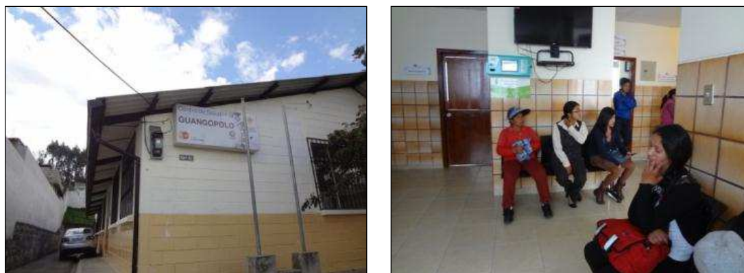
Figura 63. Instalaciones Centro de Salud Guangopolo
