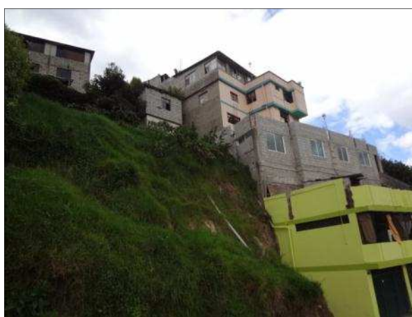
Figura 20. Área de uso residencial asentada en un área de protección ecológica
