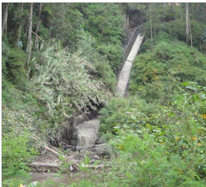
Figura 26. Canal de descarga de la Hidroeléctrica Guangopolo al río San Pedro, sector Rumiloma
