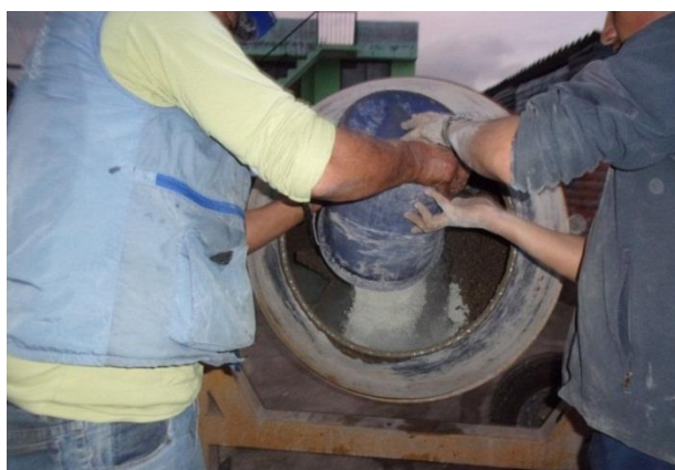
Figura 56: Fotografía de la colocación del cemento en la concretera.
