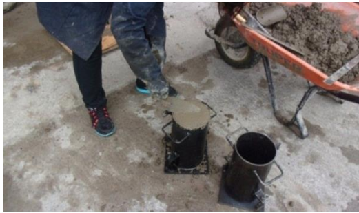
Figura 32: Fotografía de la toma de cilindros.
