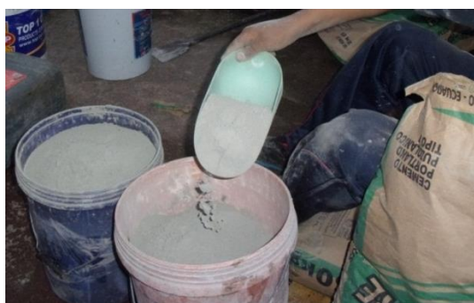
Figura 55: Fotografía de dosificación de Cemento.
