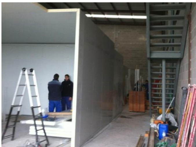
Figura 46: Paneles no portantes.
