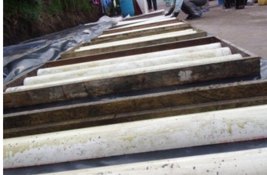
Figura 57: Fotografía de la colocación de los canales.
