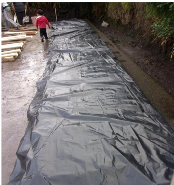
Figura 65: Fotografía de paneles cubiertos con plástico.
