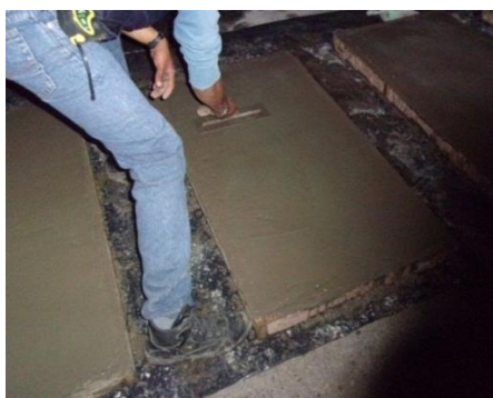
Figura 62: Fotografía paleteando el panel.
