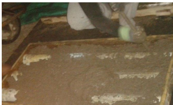
Figura 59: Fotografía de la colocación de la mezcla en los paneles.
