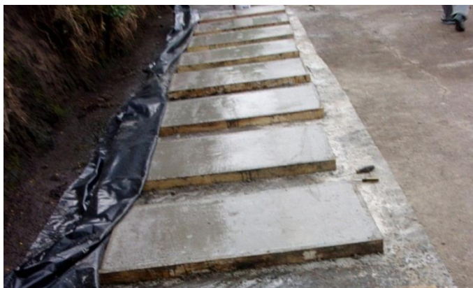
Figura 64: Fotografía de paneles húmedos.
