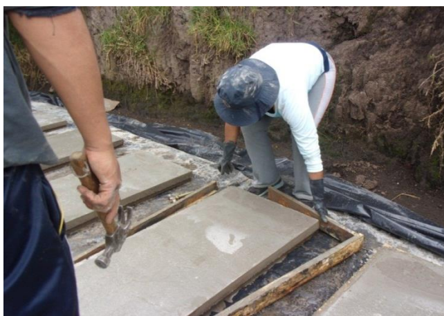
Figura 66: Fotografía del panel desencofrando.
