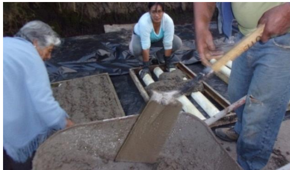
Figura 58: Fotografía de la colocación de la mezcla en los paneles.
