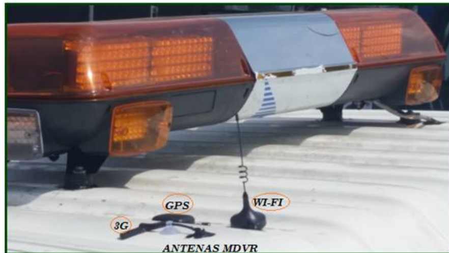
Figura 26: Instalación de las antenas: WI-FI, 3G y GPS en el vehículo blindado.
