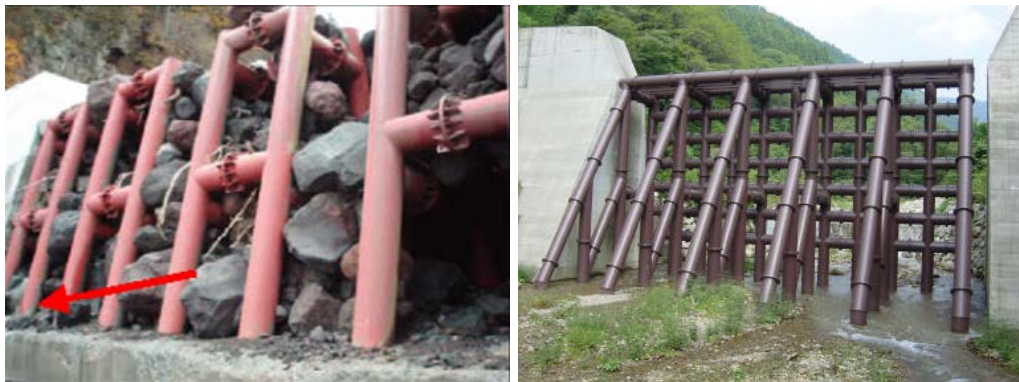
Figura 28. Presas SABO de tubos de acero
