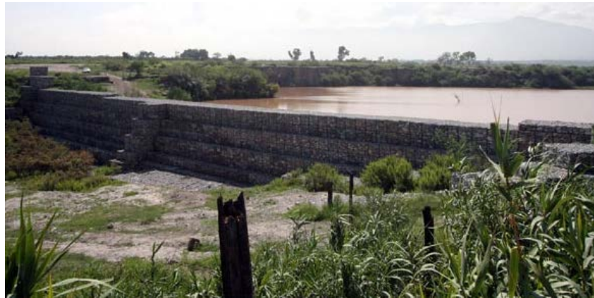
Figura 21. Presa de Gaviones
