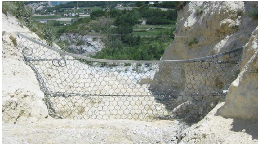
Figura 26. Barrera Flexible a Base de Redes de Anillos
