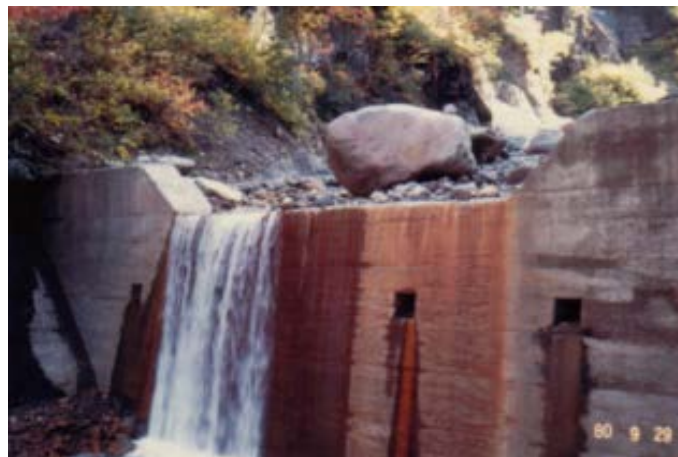
Figura 27. Presa SABO de hormigón
