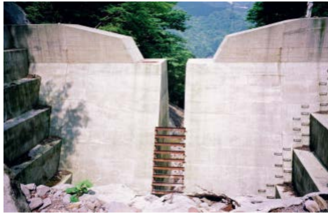
Figura 29. Presa SABO de concreto con hendidura
