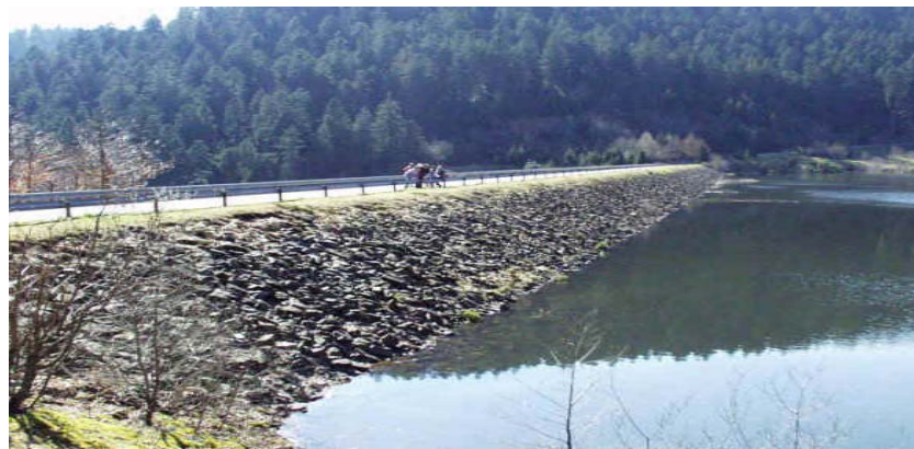
Figura 20. Presa de Enrocado Kleine Kinzig
