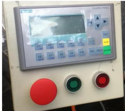
**Figura 54. Tablero de control eléctrico para el panel**
