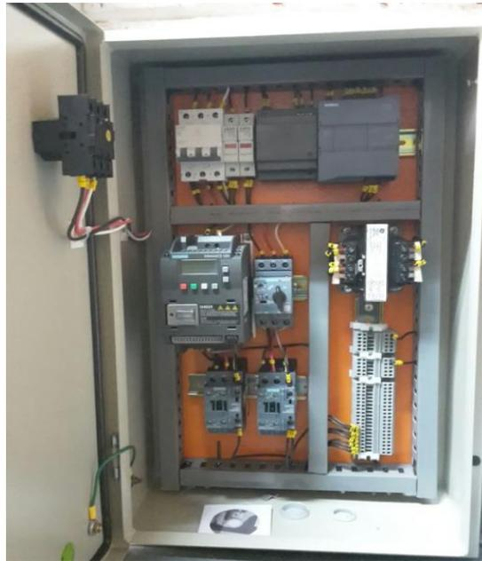
**Figura 53. Construcción del tablero de Control Eléctrico 4**
