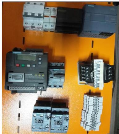
**Figura 51 Construcción del tablero de Control Eléctrico 2**
