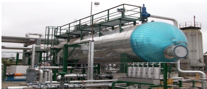
Figura 35 Construcción Refinería La Libertad
