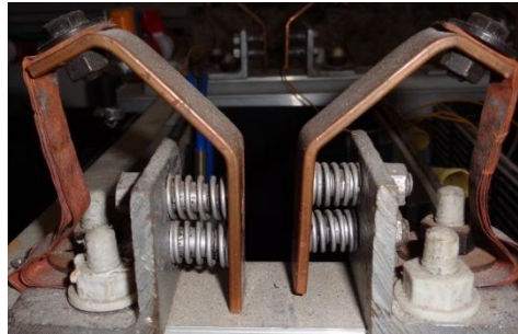
Figura 51 Ensamble dedos de contacto (Ánodos).
