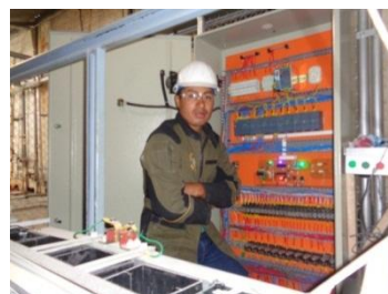
Figura 73 Ubicación permanente de la cabina
