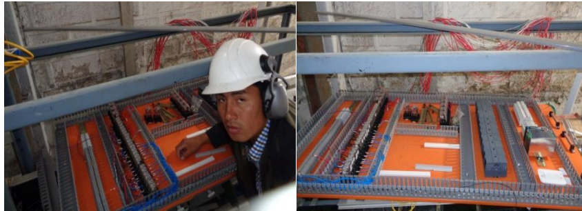
Figura 67 Colocación de canaletas y riel DIN estándar.
