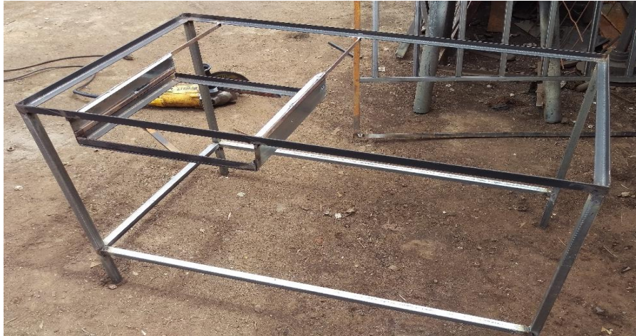
Figura 75 Construcción de la estructura metálica
