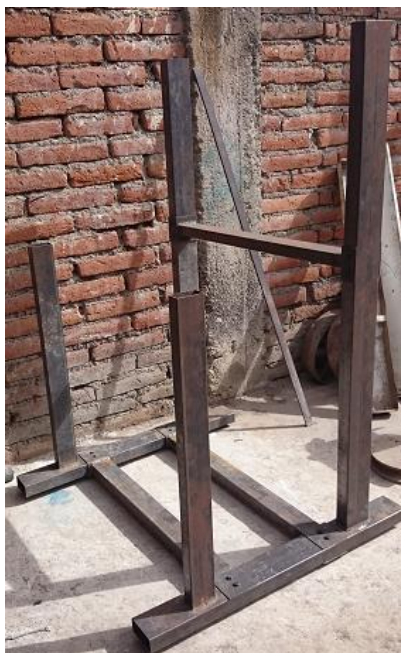
Figura 78 Construcción estructura del Módulo.
