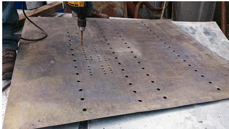
Figura 81 Proceso de perforado tablero de control.
