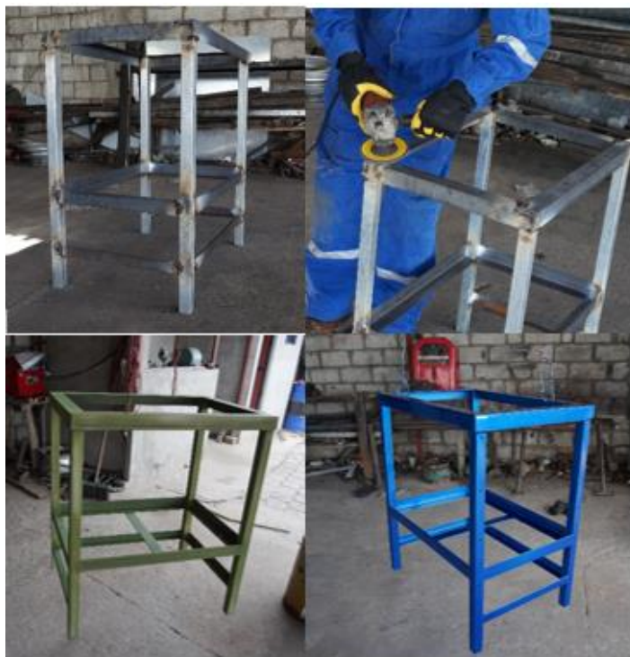
Figura 48 Construcción de la estructura metálica.
