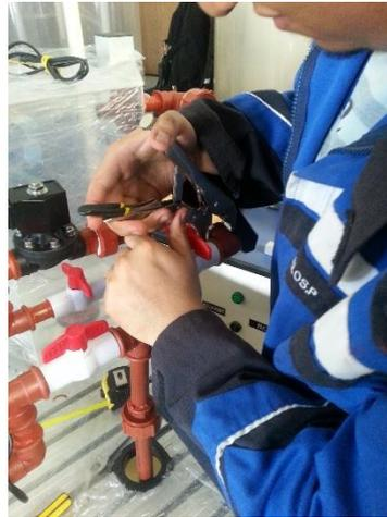
**Figura.81: Montaje del sistema hidráulico.**
