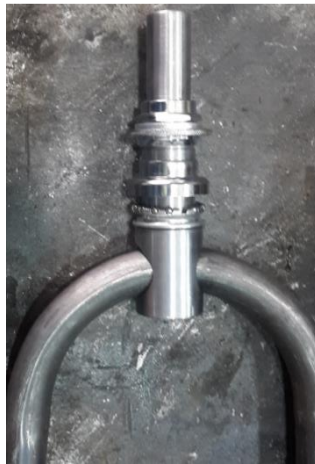
Figura 122. Tubo y arco antes de soldar.
