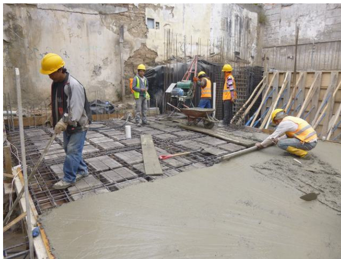
Figura 18 Construcción de loza en edificio del centro histórico Quito
