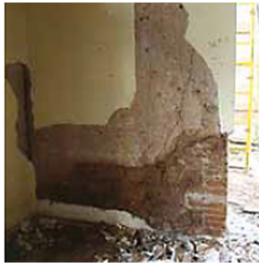
Figura 48 Vista de las dos capas de revoque, grueso y fino, Fuente: (Peñaranda, 2011).
