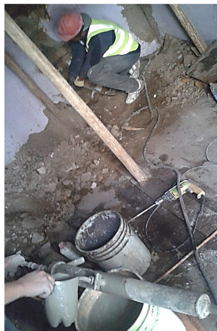
Figura 52 Inyección en muros de adobe
