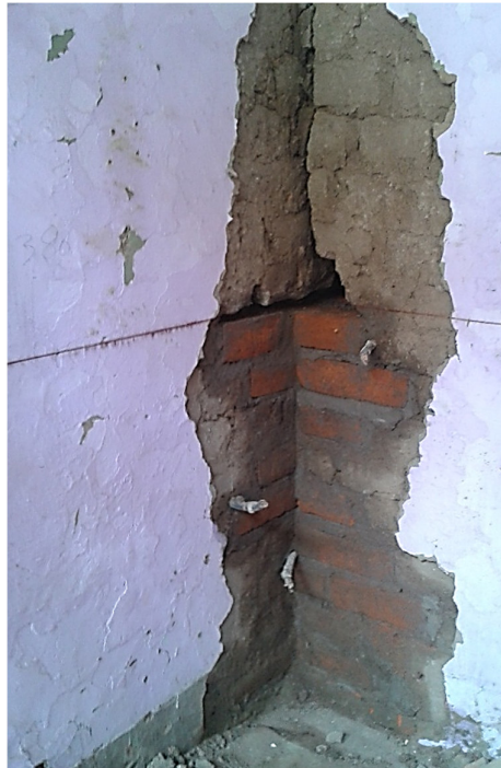
Figura 54 Cosido de un muro de adobe
