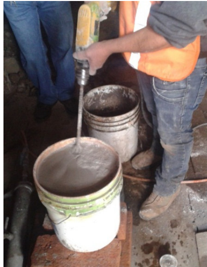
Figura 51 Preparación de mezcla para inyección en muro
