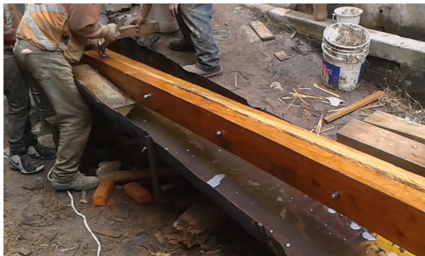
Figura 55 Tratamiento a elementos de madera
