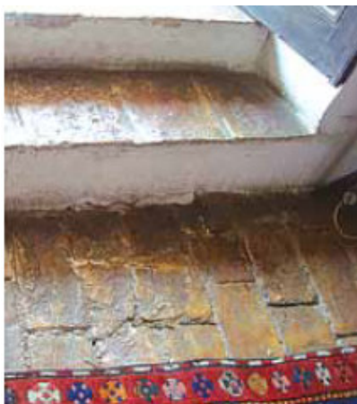
Figura 49 Piso de ladrillo pastelón, Fuente: (Peñaranda, 2011).
