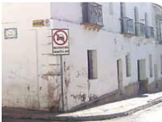
Figura 43 Humedad ascendente o por capilaridad, Fuente: (Peñaranda, 2011).
