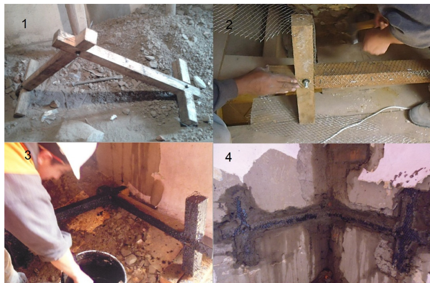
Figura 53 Elaboración y colocación de una llave de madera
