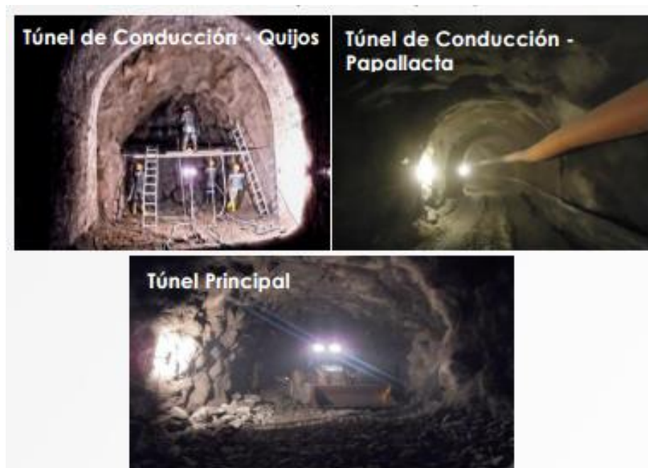
Figura 5 Avance de Obra
