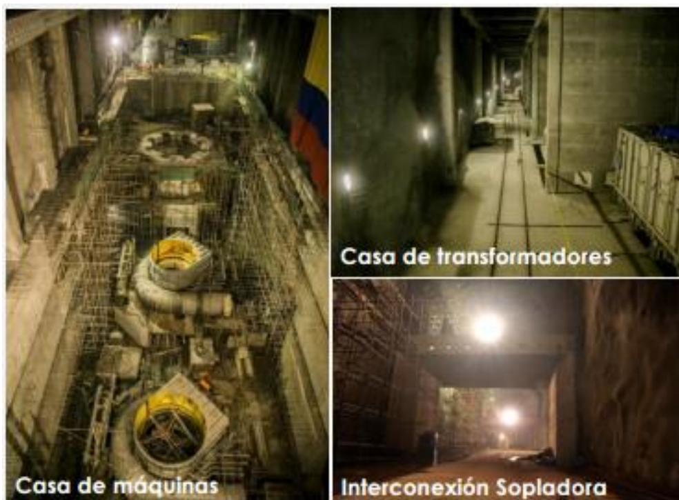
Figura 6 Avance de Obra
