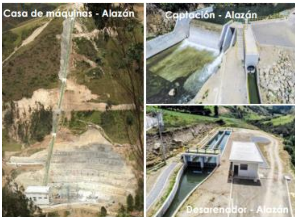
Figura 3 Avance de Obra
