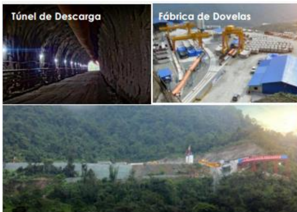
Figura 4 Avance de Obra
