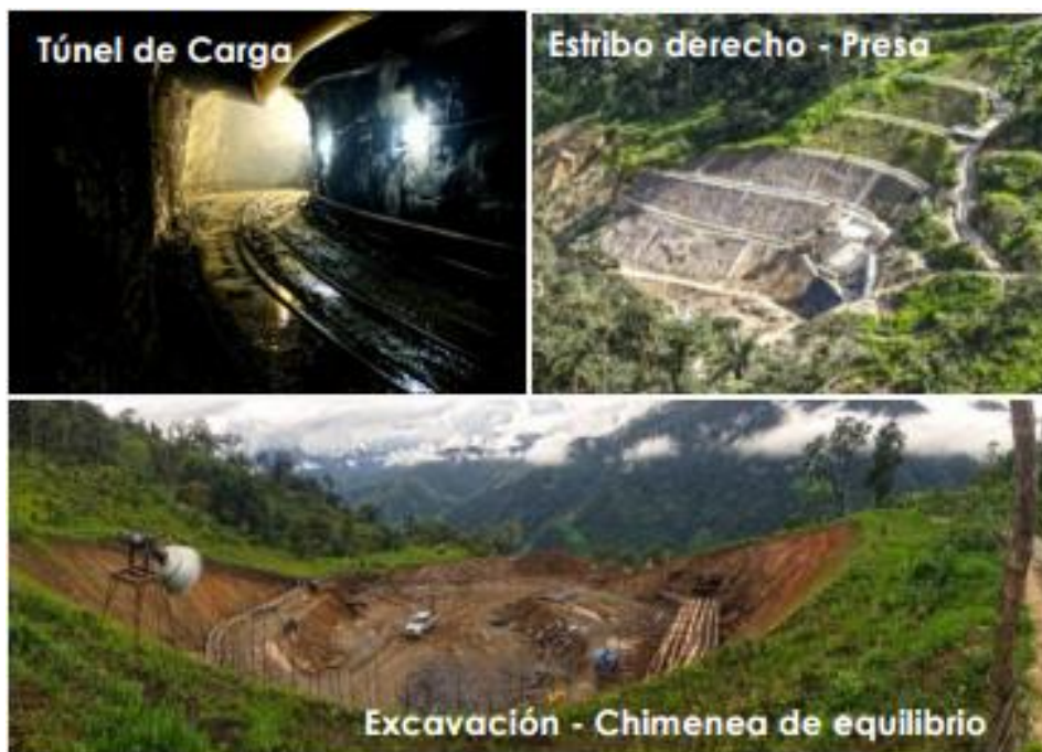
Figura 2 Avance de Obra
