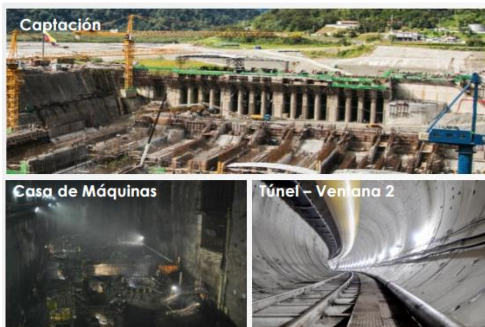
Figura 1 Avance de Obra
