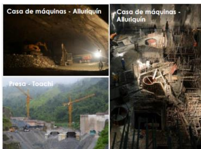
Figura 7 Avance de Obra
