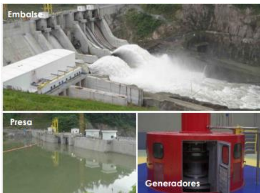
Figura 3 Avance de Obra
