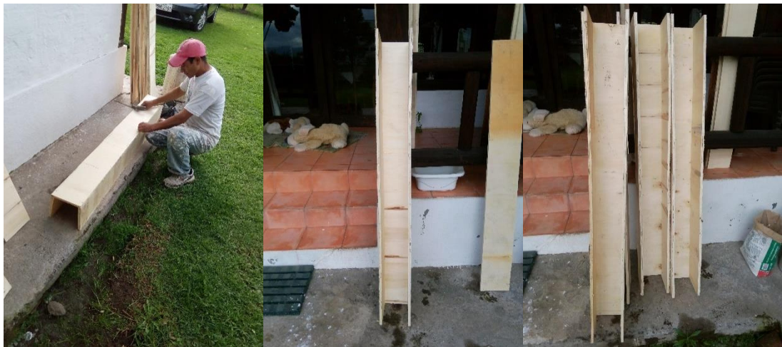
Figura 40. Ensamble de encofrados.
