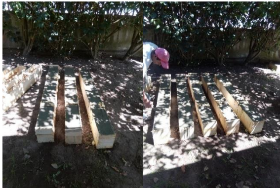
Figura 43. Fundición de vigas (2).
