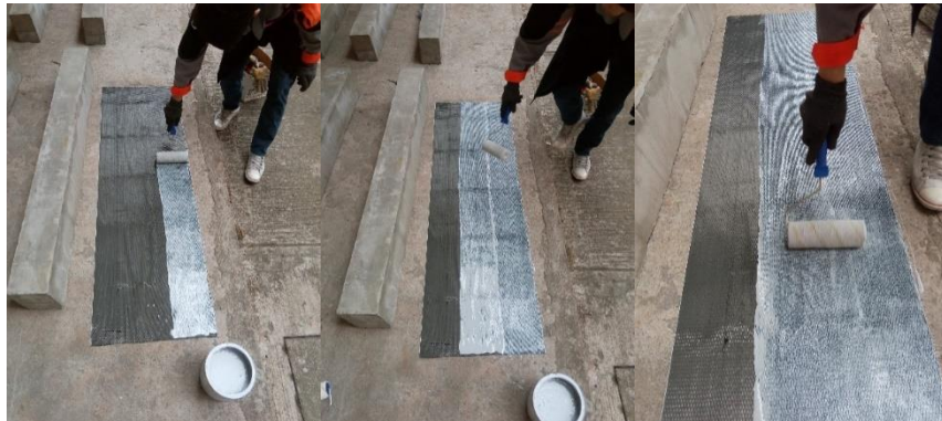
Figura 53. Impregnación de pegamento Sikadur 301 sobre fibras.
