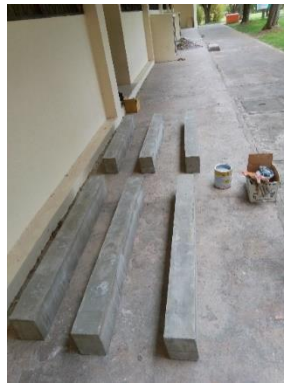
Figura 52. Colocación de vigas en posición para reforzamiento.
