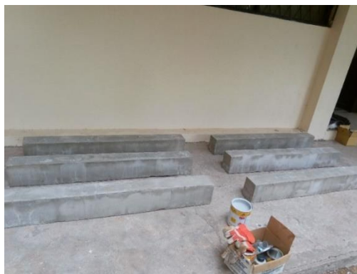
Figura 47. Colocación de vigas en posición para el reforzamiento.
