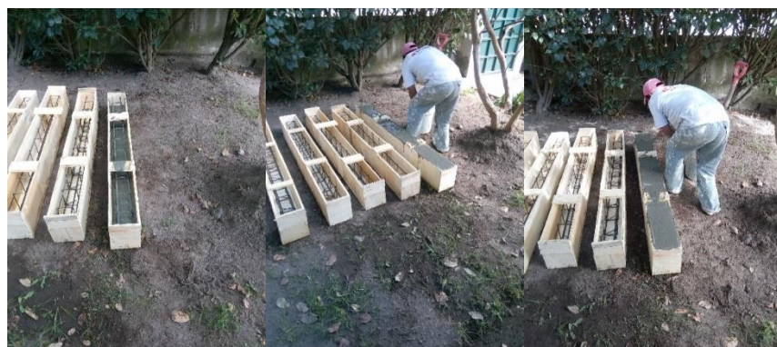
Figura 42. Fundición de vigas.
