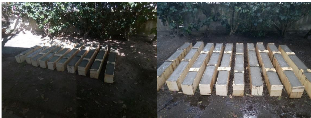
Figura 44. Fundición de vigas (3).
