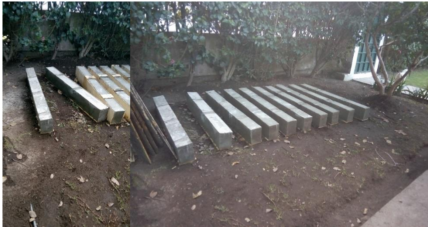
Figura 45. Desencofrado de vigas.
