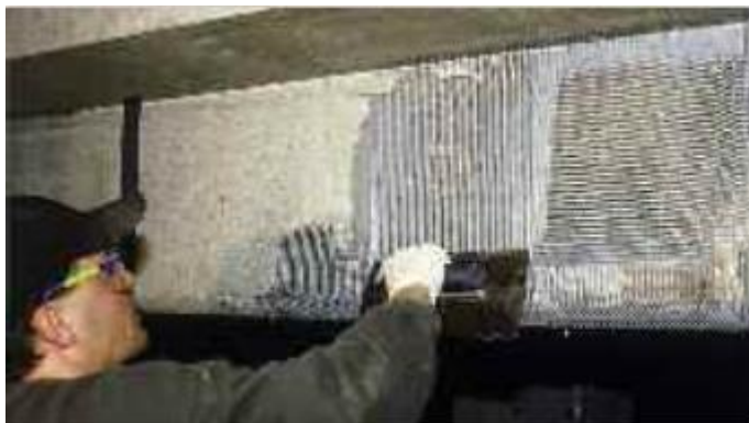
Figura 10. Aplicación de resina sobre viga de hormigón preparada
