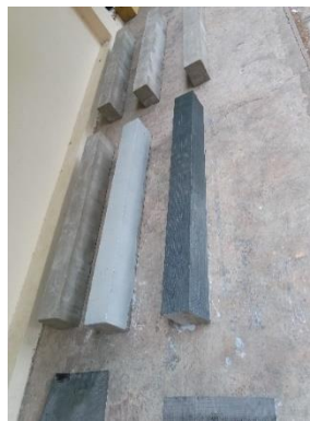
Figura 49. Colocación de refuerzos sobre vigas.
