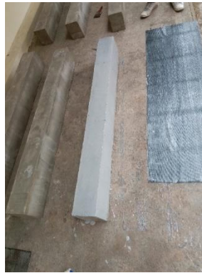
Figura 48. Impregnación de adhesivo epóxico sobre superficies de vigas.
