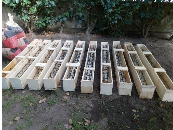
Figura 41. Colocación de armaduras en el interior de los cajones.
