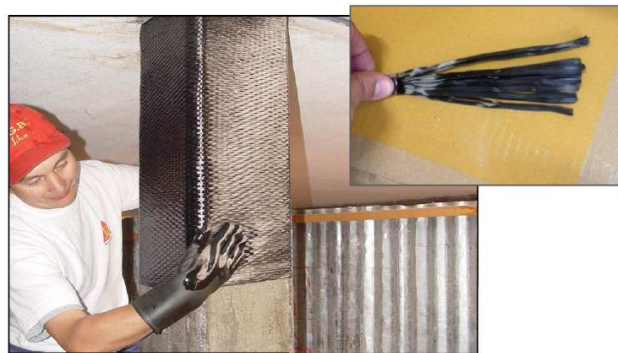
Figura 13. Reforzamiento de columnas con fibra de carbono.
