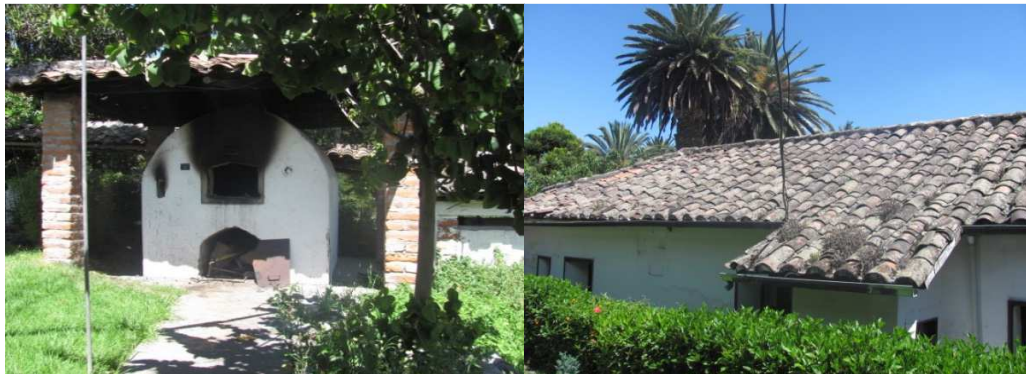
Figura 44: Horno y techo antiguo
