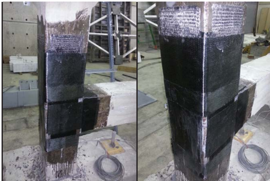
Figura 134: Piezas recortadas de Fibra de carbono y colocación con epóxico.
