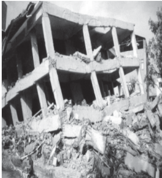
Figura 35: Falla de unión viga-columna, Terremoto 17 de agosto de 1999, Koacaeli Turquía Fuente: (Aguar, Revelo, & Tapia, 2013)
