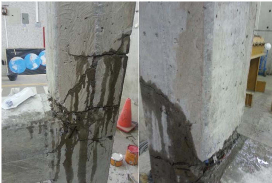
Figura 131: Limpieza de impurezas con inyección de agua a presión.
