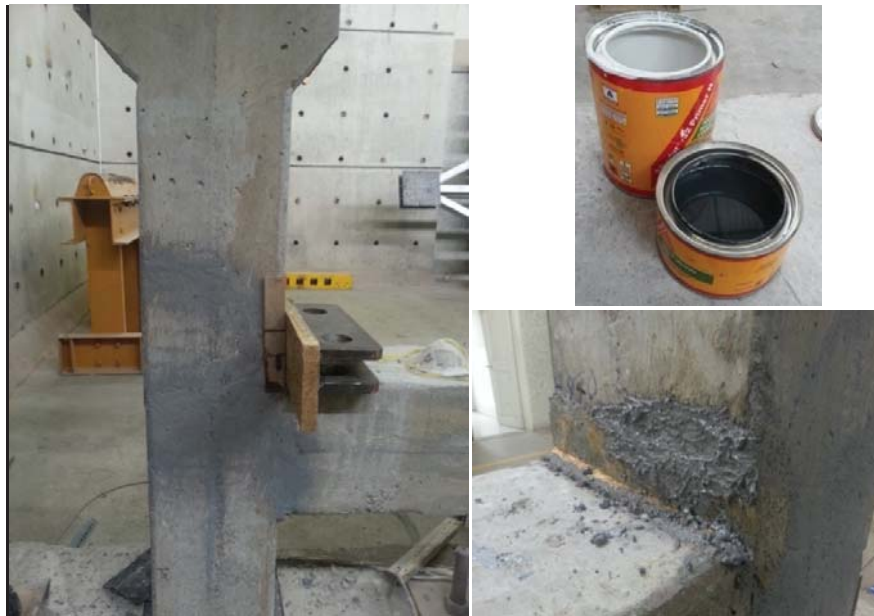
Figura 132: Relleno de grietas y fisuras con mezcla de epóxico (A+B).
