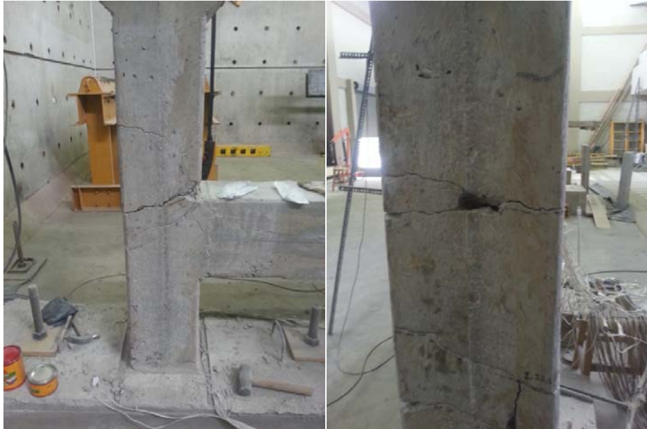
Figura 130: Retiro de residuos de hormigón de la probeta.
