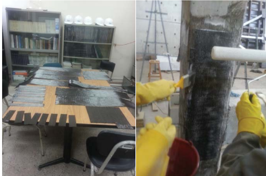
Figura 134: Piezas recortadas de Fibra de carbono y colocación con epóxico.
