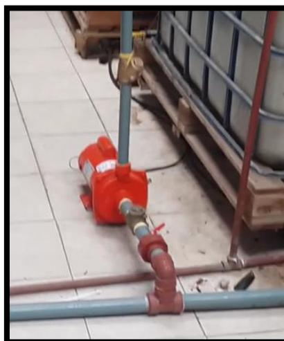
**Figura 86:** Ubicación y conexión de la bomba EVANS 3HME100
