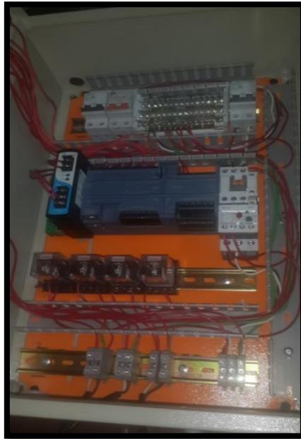
**Figura 85:** Cableado de tablero de control
