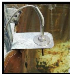
**Figura 88:** PT100 con soporte de fijación en Tanque
