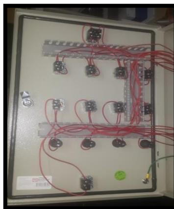
**Figura 84:** Cableado de pulsadores y luces piloto
