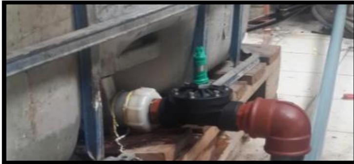
**Figura 74:** Acople electroválvula tanque 2
