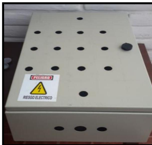
**Figura 82:** Perforación en puerta de tablero
