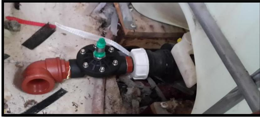
**Figura 73:** Acople electroválvula tanque 1
