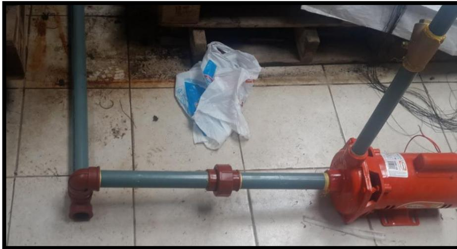
**Figura 78:** Conexión tubería a línea de succión bomba
