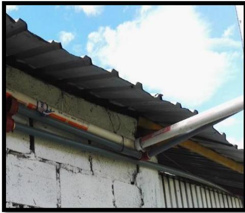
**Figura 86:** Conexión de tubería de retorno a ingreso de la planta
