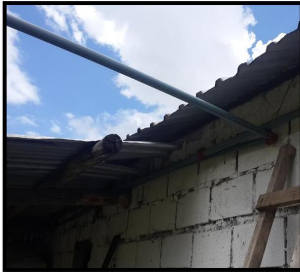
**Figura 81:** Línea de descarga exterior de bomba
