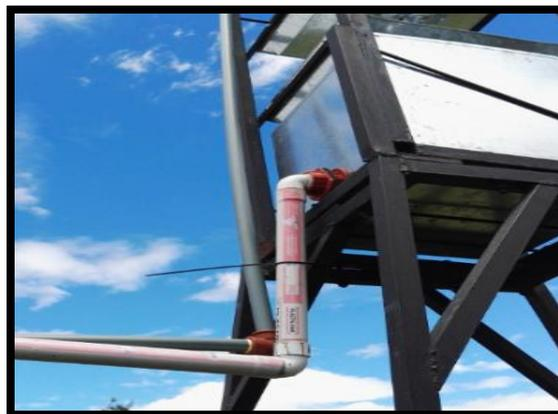
**Figura 85:** Conexión en reservorio a circuito de retorno de agua
