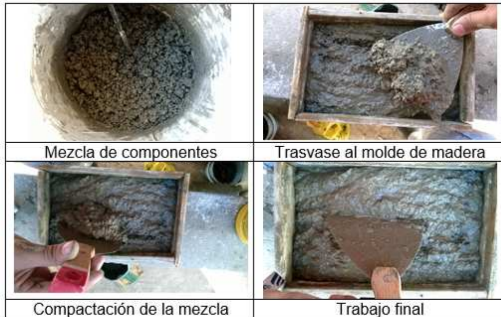
Figura 16. Pasos para la fabricación del bloque de cemento
