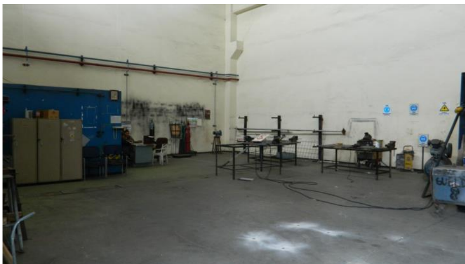
Fotografía 14. Hangar de mantenimiento
