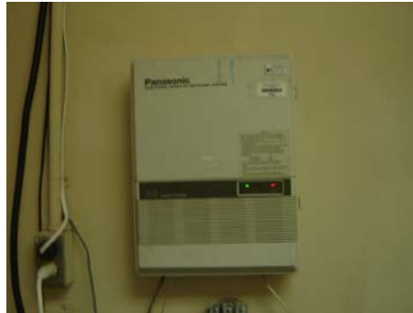
Figura. 2.5. Central Telefónica Panasonic Cabecera.
