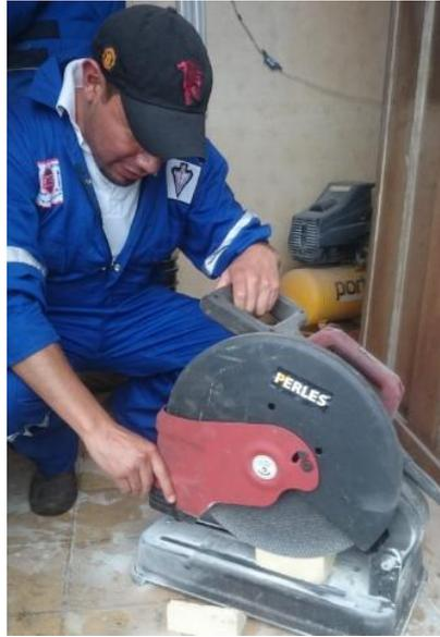
**Figura 29 Corte del exceso de ladrillo**
