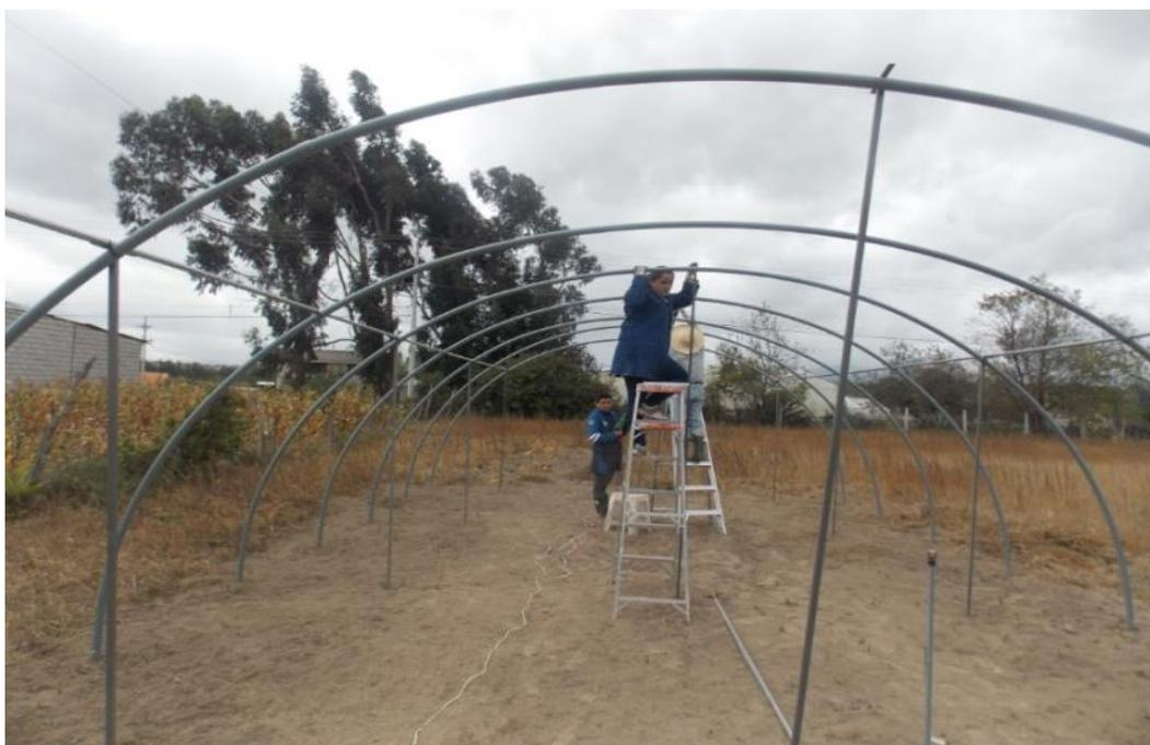
**Figura 32: Colocación tubo circular de ½ pulgada, para la cumbre del invernadero.**
