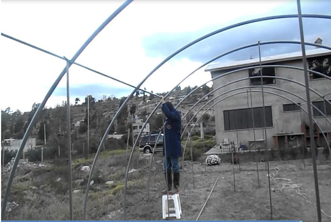
**Figura 30: Formación de arcos con tubos PVC para el invernadero.**
