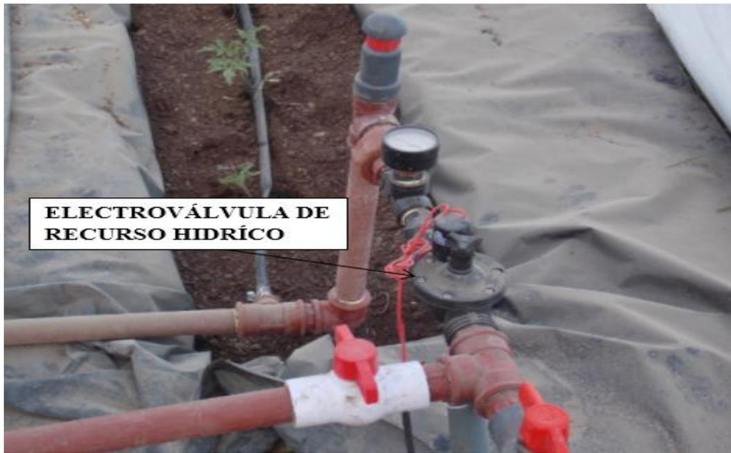
**Figura 44: Colocación del actuador para el control de recurso hídrico.**
