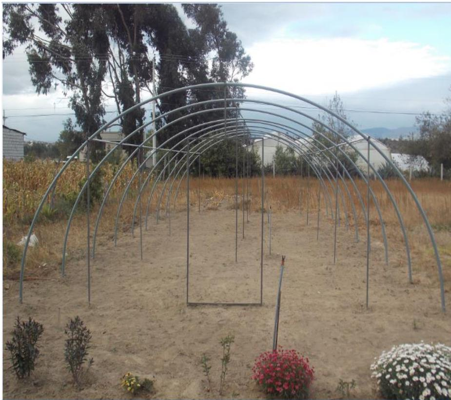
**Figura 33: Estructura final del invernadero tipo túnel.**
