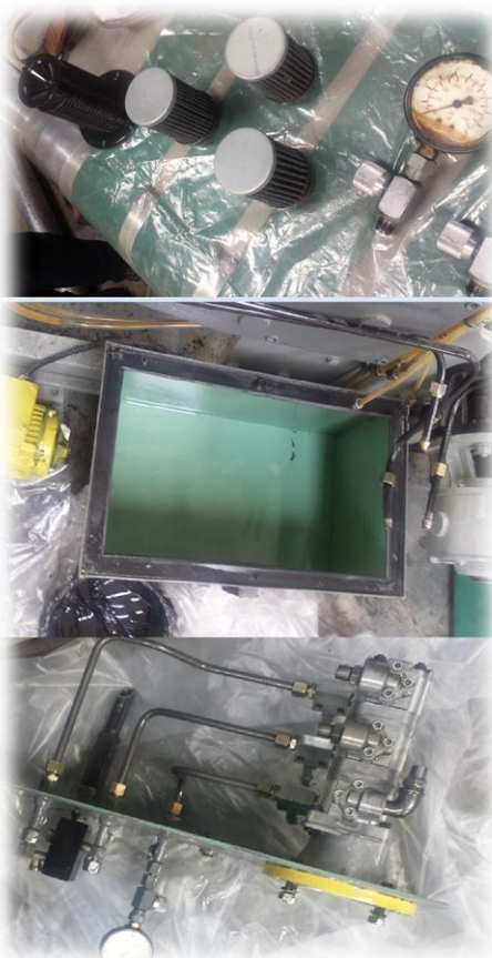
Figura 64: Limpieza del tanque de la bomba hidráulica
