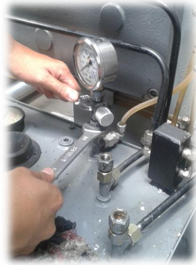
Figura 74: Colocación del primer manómetro
