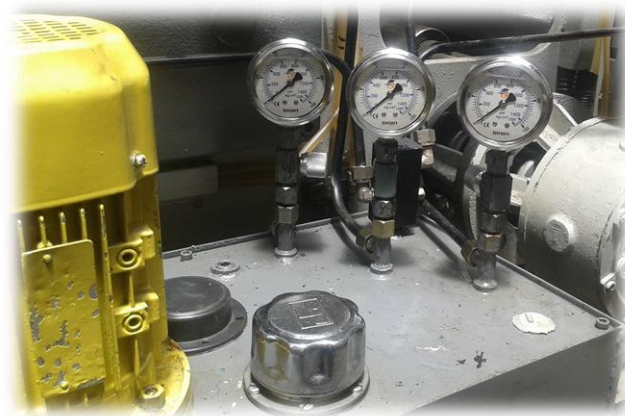
Figura 75: Manómetros nuevos colocados en la bomba hidráulica
