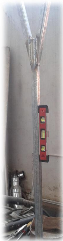
Figura 79: Nivelación de estructura
