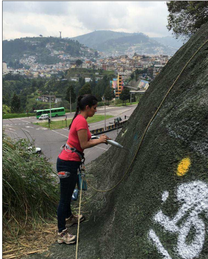
Figura 17. Ejecución del ensayo esclerométrico
