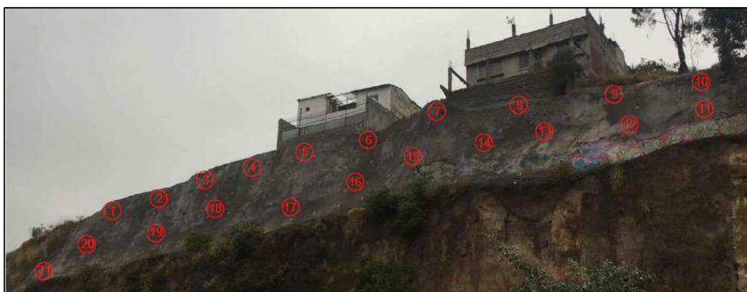
Figura 49. Puntos ensayados con esclerómetro Talud N°3
