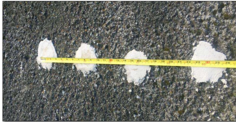
Figura 23. Medición de velocidad de impulso por transmisión indirecta
