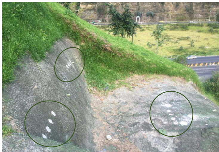
Figura 24. Puntos aleatorios para el ensayo sobre los taludes
