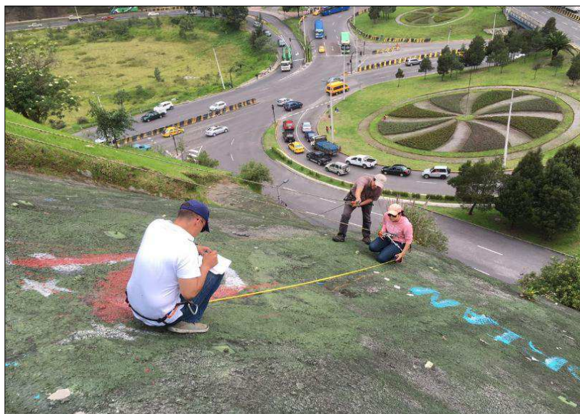
Figura 54. Medición de fisuras Talud N°1
