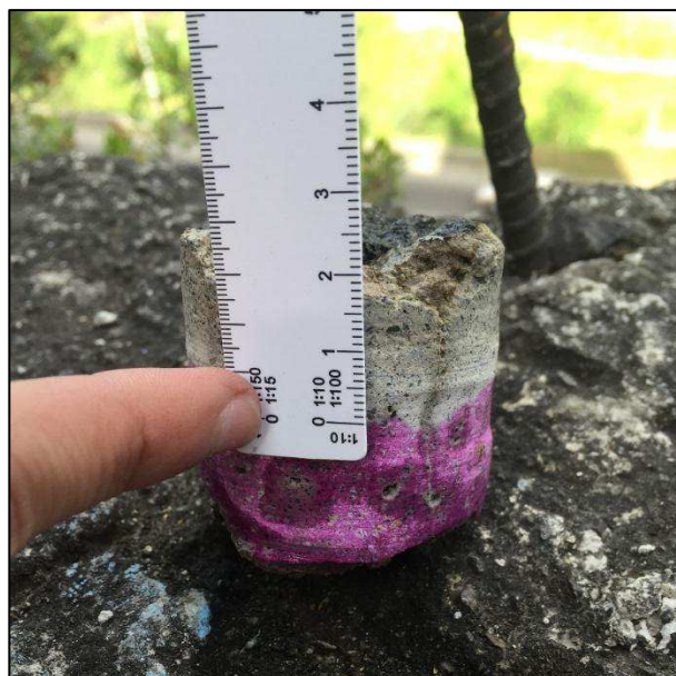
Figura 56. Ensayo de carbonatación Talud N°2
