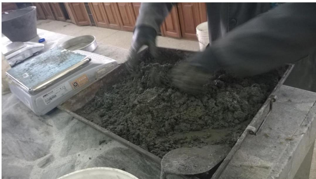
**Figura 4.6** Mezcla homogénea de cemento, cascarilla, arena y agua utilizando las manos.
