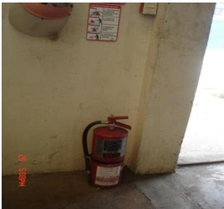
**Figura 61** Extintores portátiles sin señalización ni mantenimiento
