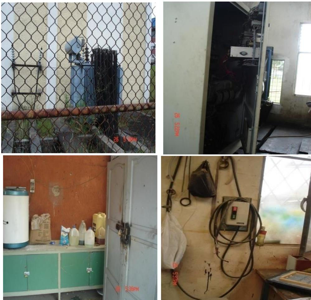
**Figura 51** Instalaciones eléctricas en mal estado, sin señalización de voltajes
