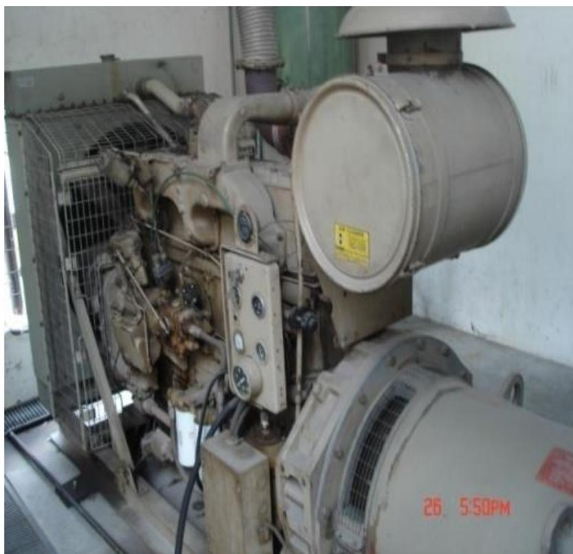
**Figura 53** Generador Cumins de 150 KVA
