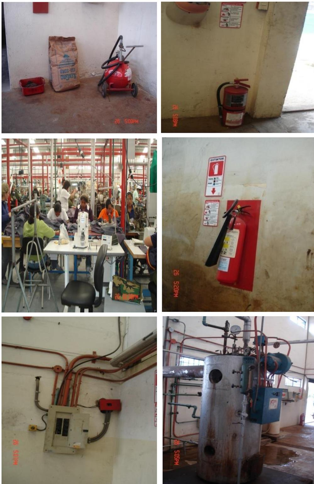
**Figura 64** Señalización inadecuada de tubería y extintores de incendio
