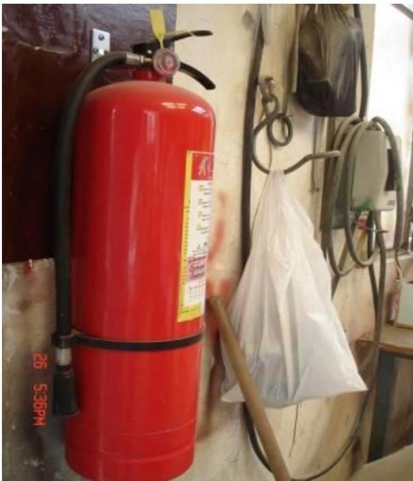
**Figura 62** Extintores portátiles sin señalización en caldero
