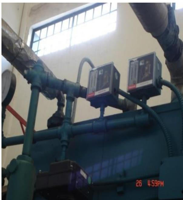
**Figura 55** Caldero tipo vertical con controladores (vista superior)
