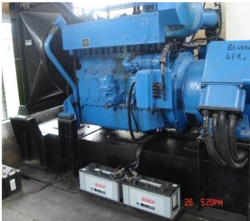
**Figura 52** Generador Deutz de 360 KVA
