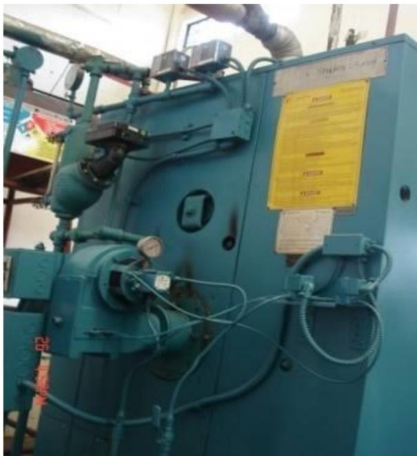
**Figura 54** Caldero tipo vertical con controladores (vista frontal)
