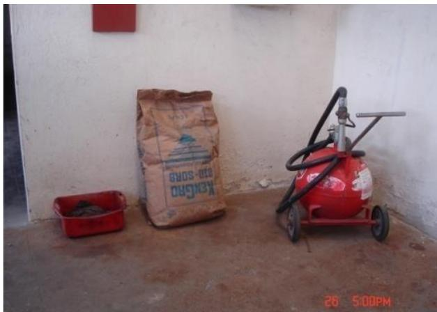
**Figura 60** Extintores portátiles sin señalización
