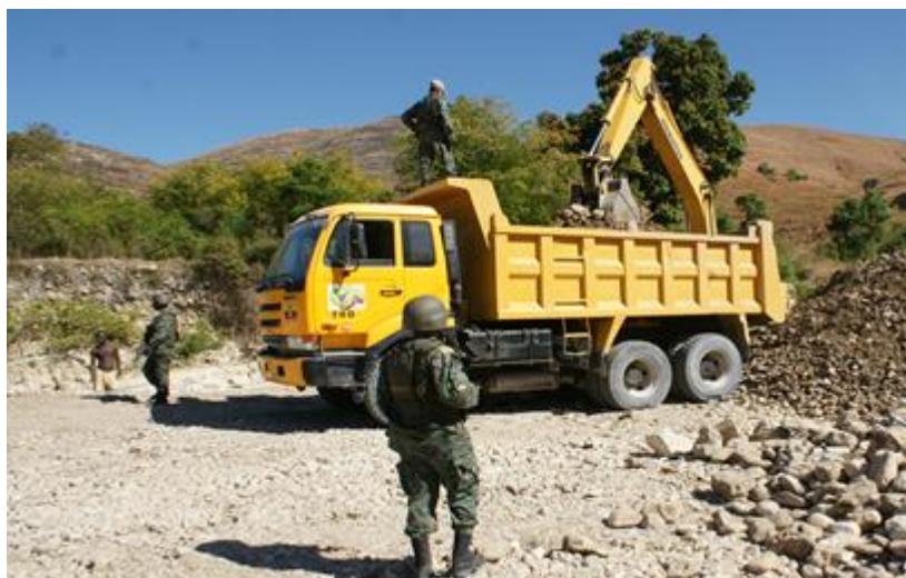
Figura No 9. Trabajos de reconstrucción en Artibonite - MARHEC.
