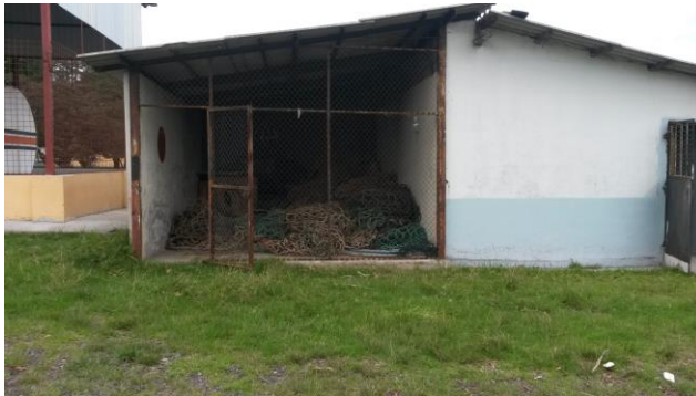
Figura 26 y 27 Área de almacenamiento de cartón, contenedores, tanques y cabos
