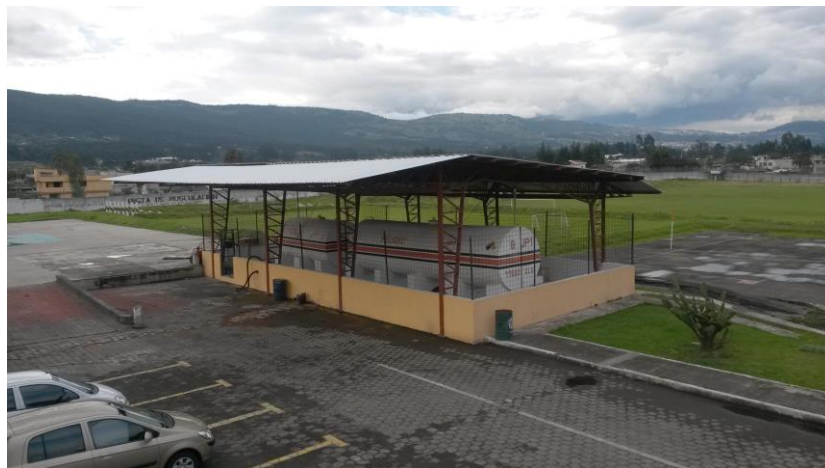
Figura 24 Área de almacenamiento de combustibles
