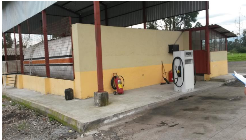
Figura 25 Área de abastecimiento y almacenamiento de gasolina
