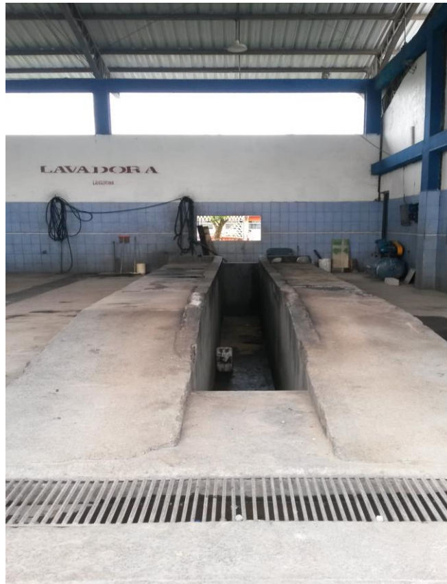
Figura 33 Lavadora de autos
