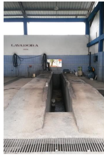
Figura 93 Lavadora de autos
