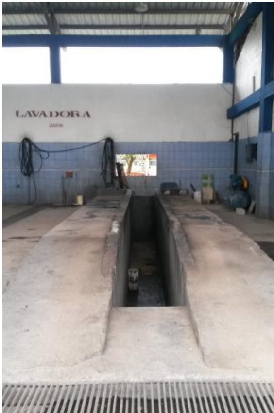
Figura 65, 66 Lavadora de autos y mantenimiento automotriz no cuenta con trampa de grasas
